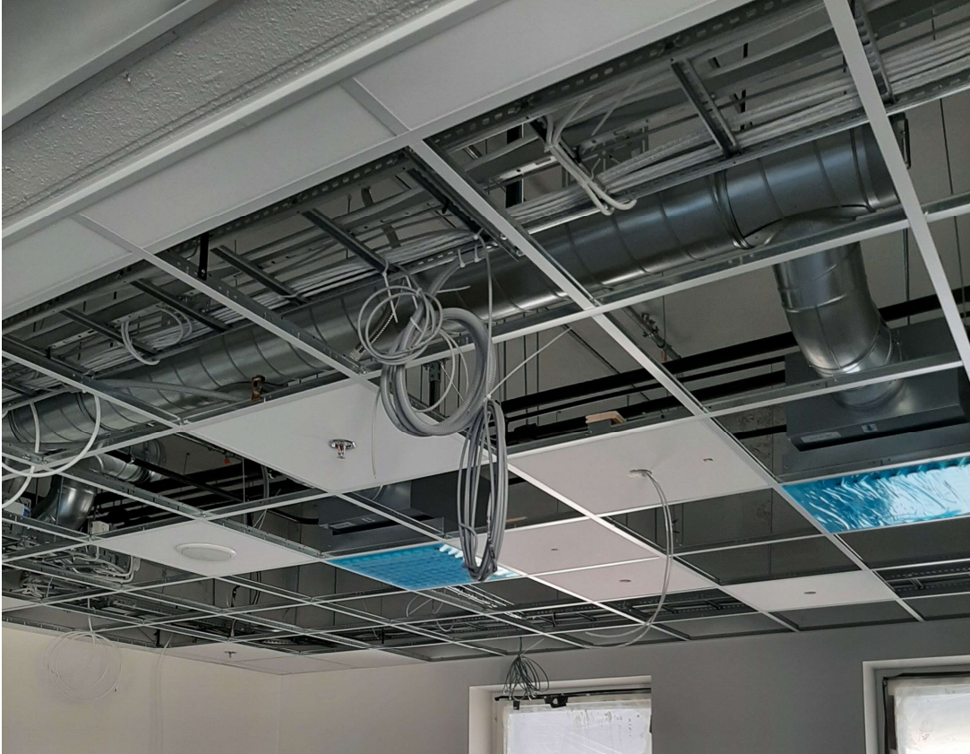
KUVA 10. Tekniikkalevyt paikoillaan
