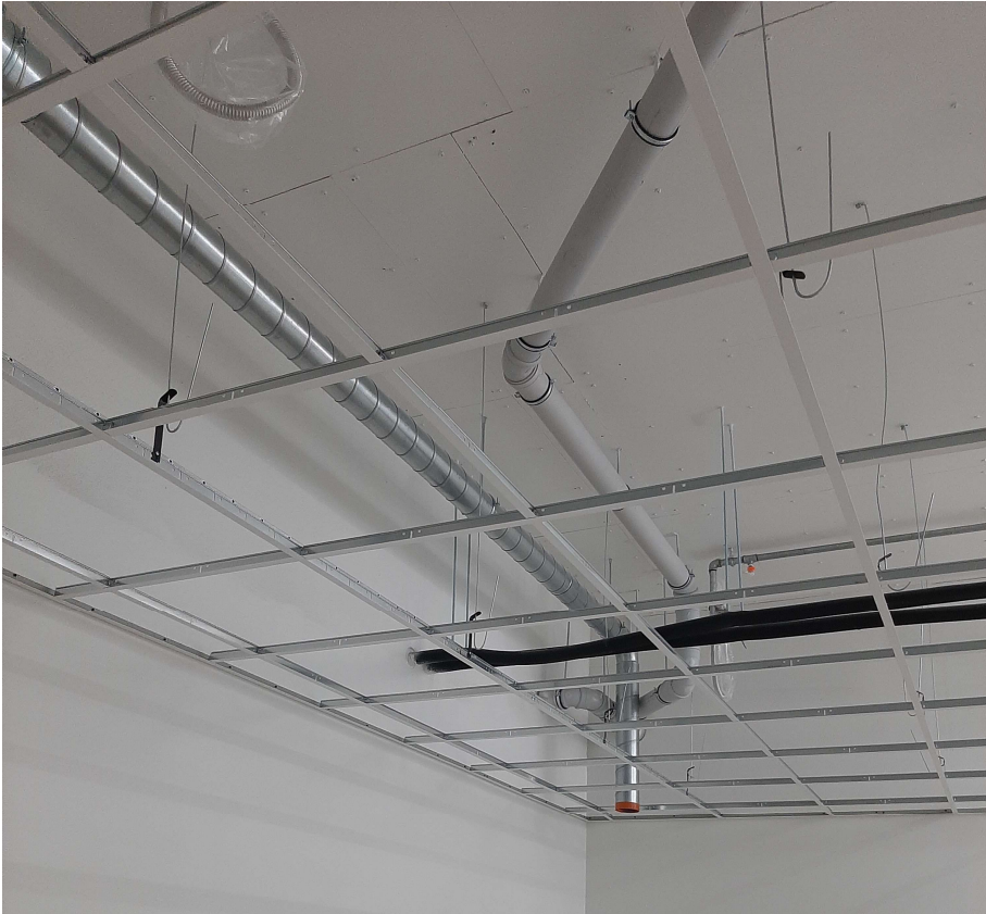
KUVA 9. T-listajärjestelmän runko valmis
