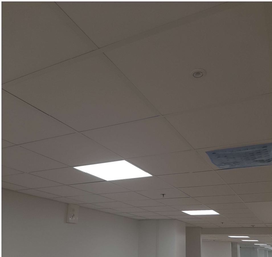
KUVA 11. T-lista-alakatto laitettu umpeen
