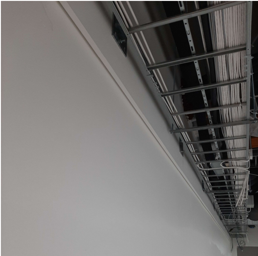
KUVA 6. Kaksoiskulmalista muodostaa varjon listan ja seinän väliin
