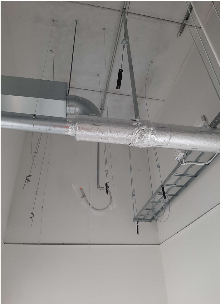
KUVA 8. Kannatinlangat ja ripustusjouset asennettu
