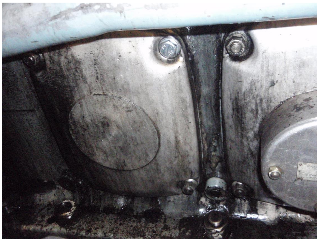
Kuva 9. Etupuolen räjähdysluukut (kuva Liisa-MaijaPalviainen)
