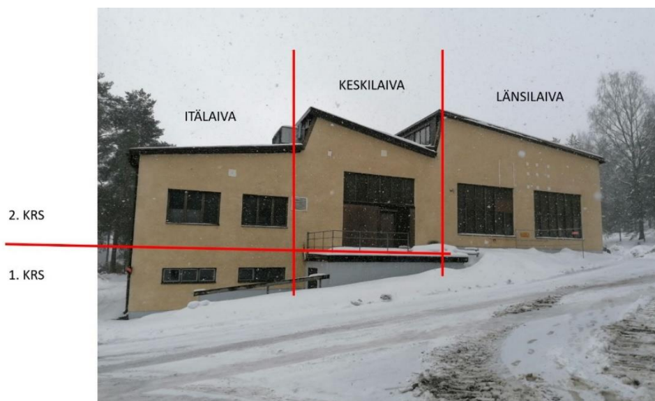
Kuva 4. Rakennuksen pohjoispääty ja rakennuksen osat.
