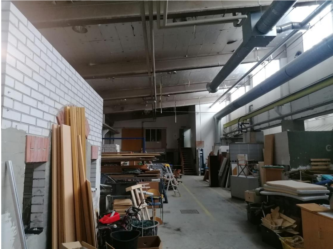
Kuva 5. Rakennuksen 2. kerroksen teollisuustilat. Kuvassa näkyy länsilaivan kattoa kannattelevat suorakulmapalkit, sekä ikkunat, joiden yläreuna ulottuu aivan kattopintaan asti.
