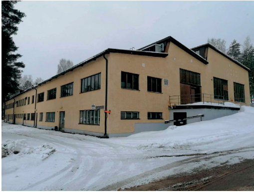
Valokuva rakennuksesta Vihdintieltä.
