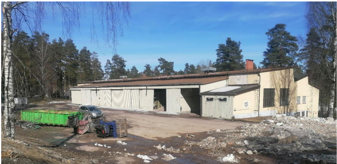
Kuva 9. Kuva rakennuksen lounaisnurkasta. Etualalla rakennuksen länsireunan peltivarasto.
