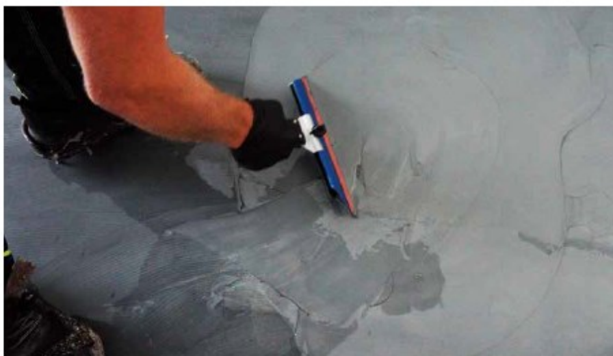
Sikafloor®-3000 FX levitetään lattiapintaan ja kuviodaan käyttäen erilaisia työvälineitä. Lattia saa uniikin kuviinnin työvälineestä riippuen.
