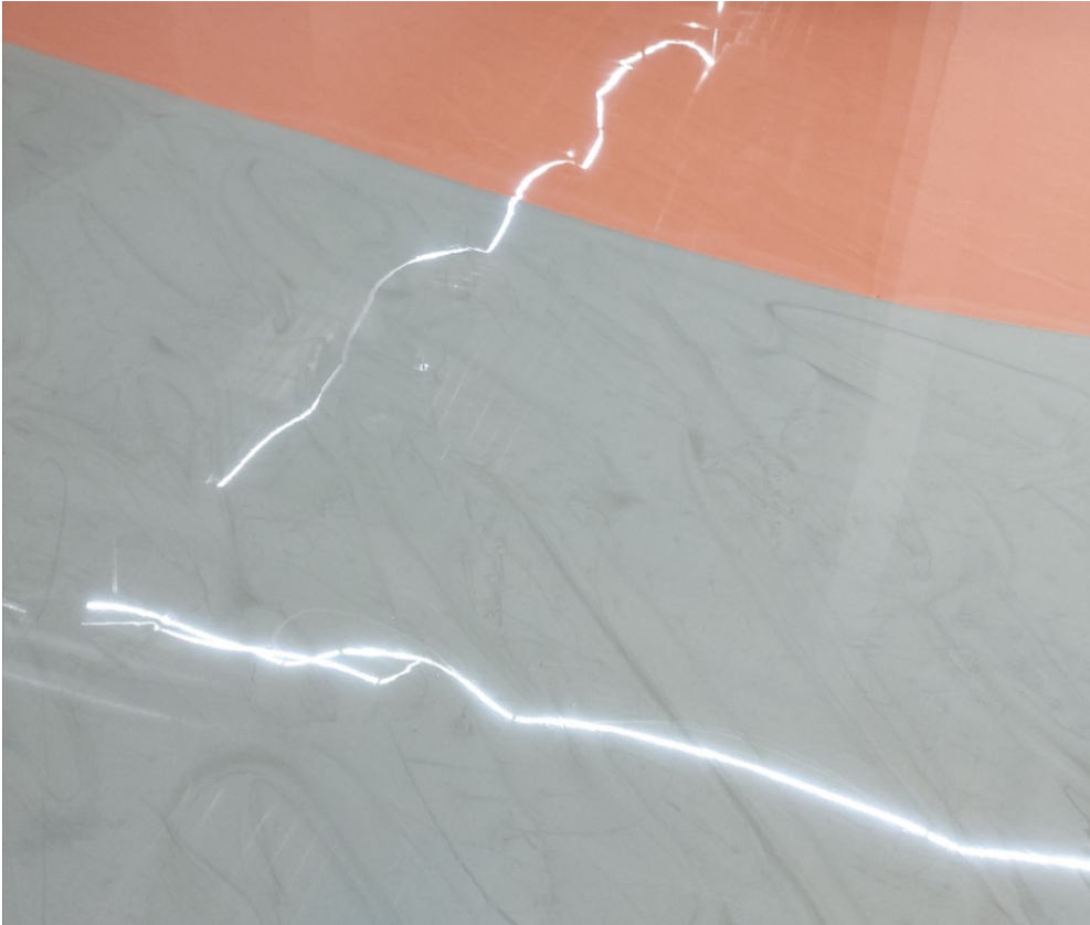
Kuva 10, valmis pinta ennen lakkausta
