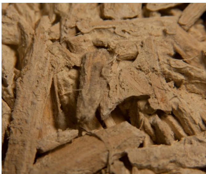
Kuva 16. Koekappaleessa F havaittu homekasvu tarkastelujakson lopussa
