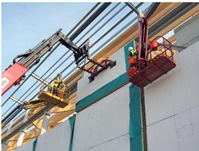
Kuva 6. Hemclad -elementin asennusta (Limetechnology 2014)
