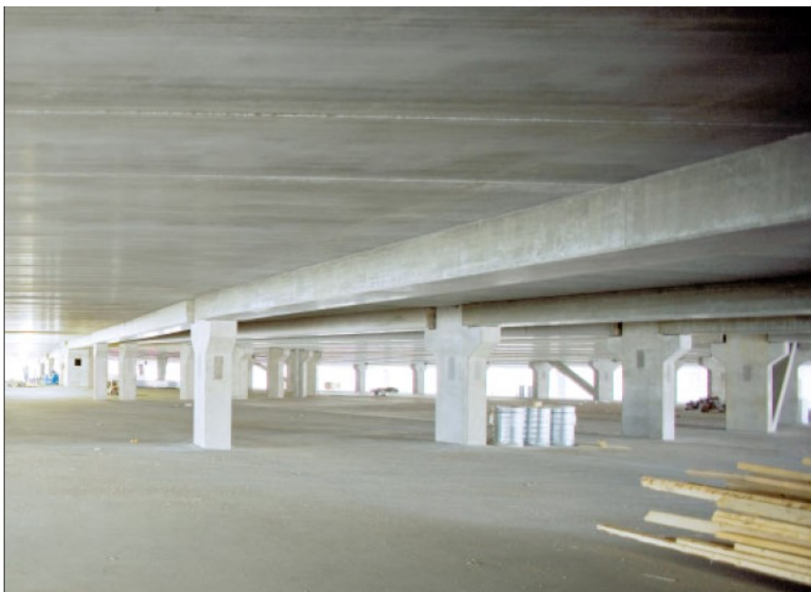
Kuva 9. Elementtirakenteinen pysäköintirakennus. (Mannonen 2008, 67.)
