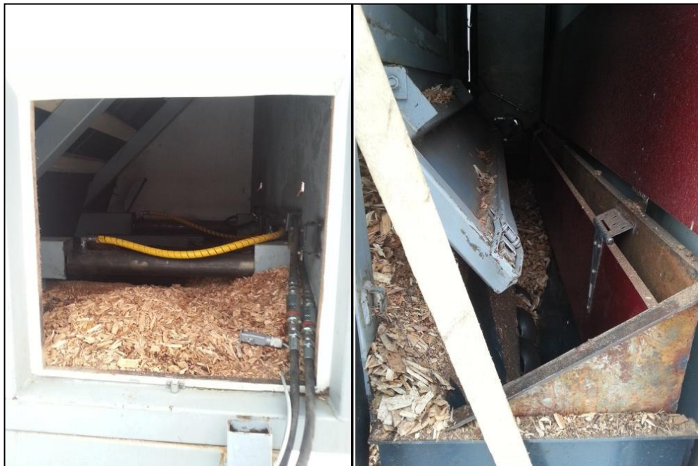
KUVIO 7. Hydraulisyliinterit liikuttavat hakevaraston pohjalla olevia tankoja.
