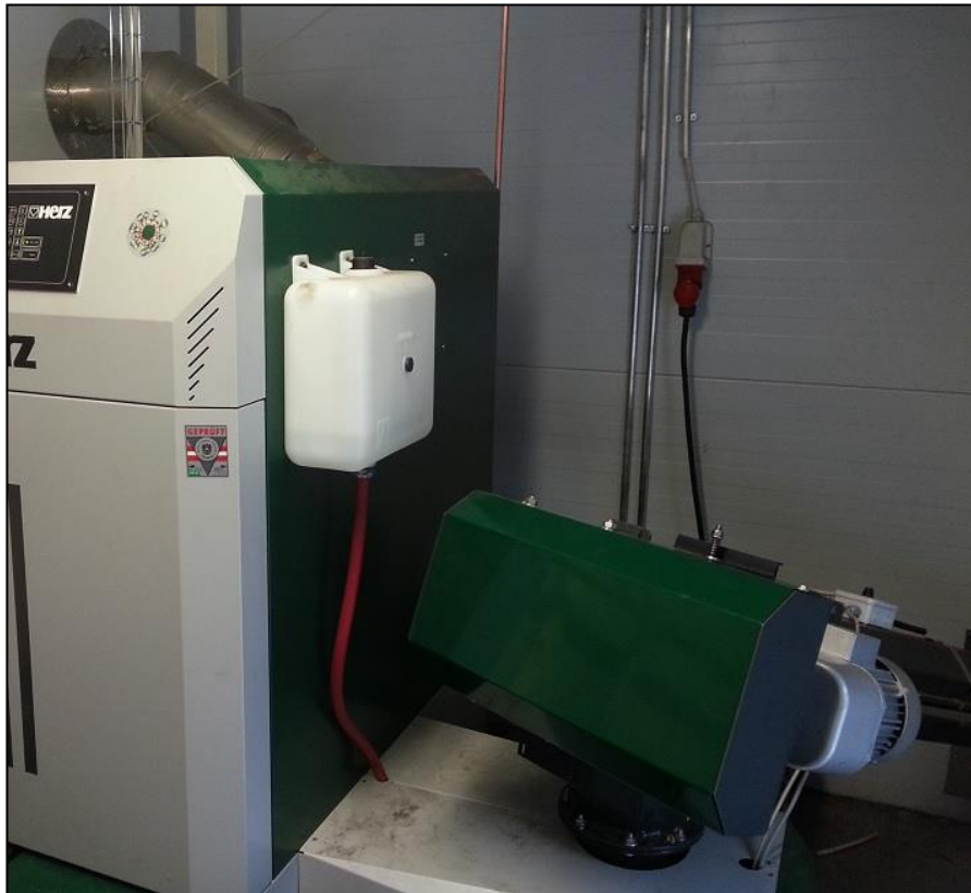
KUVIO 4. Savupiipun alkupäätä kuvassa vasemmalla ylhäällä ja syöttöruuvi kuvassa oikealla alhaalla
