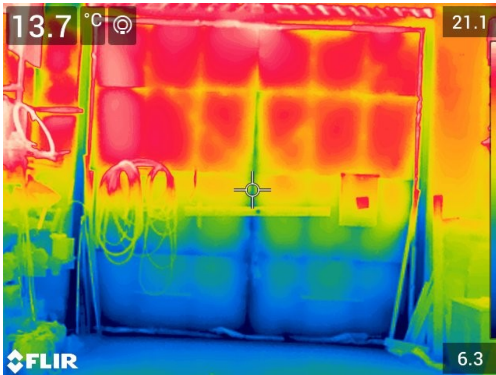
Kuva 16. Hallin pariovet, lämpökuva 5.
