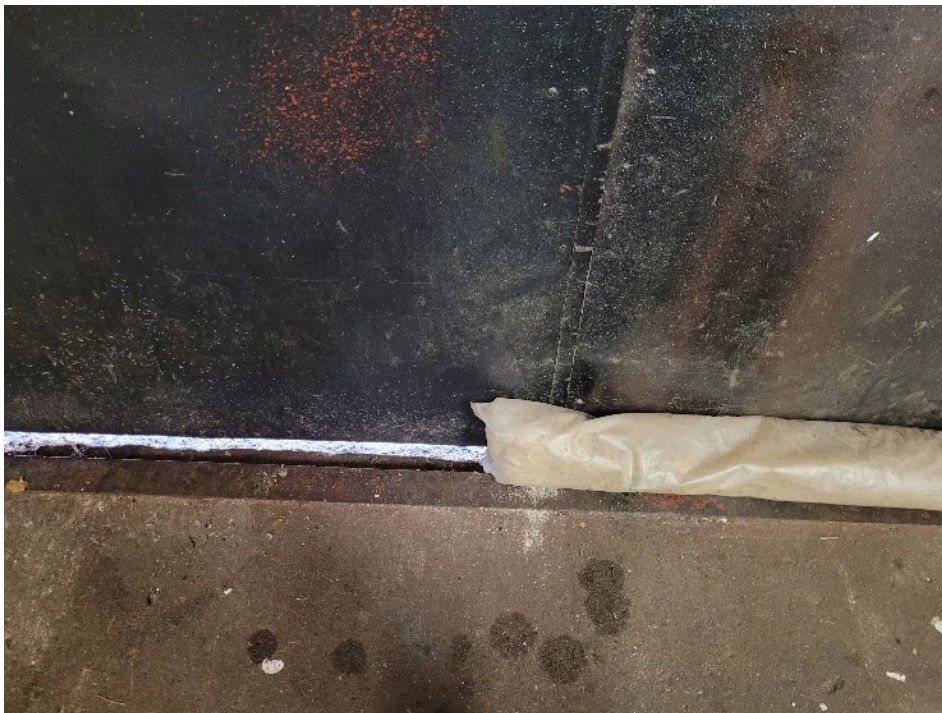
Kuva 17. Havainnekuva pariovien alareunan ilma-araosta sekä tiivistykseen käytettävästä purupussista.
