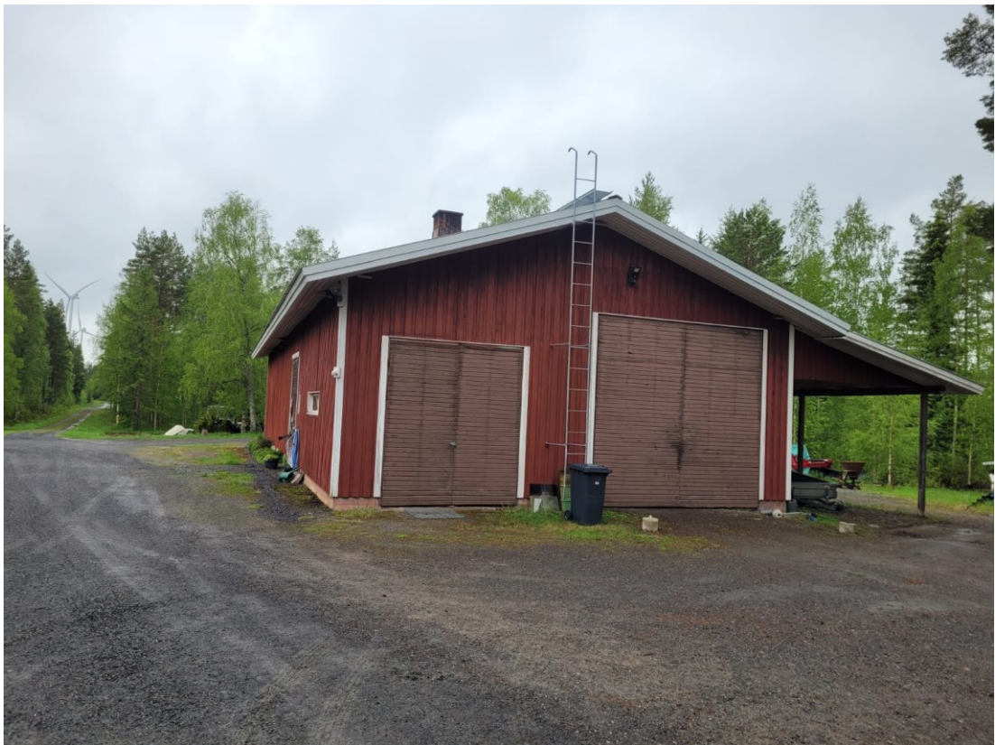
Kuva 1. Siikaisissa sijaitseva hallirakennus.
