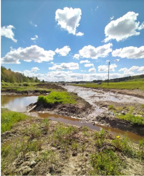
KUVA 10. Maanrakennuskäyttöön otettu peltoheitto, kohde 74.
