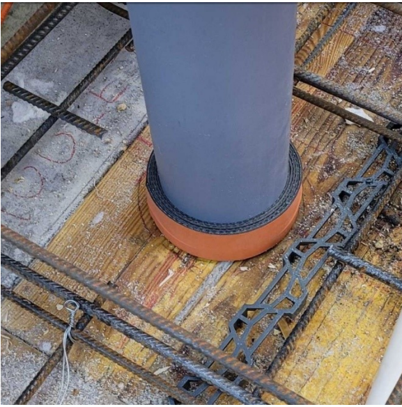
Kuva 3. Wrap-nauha asennettuna viemäriputkeen ennen betonivalua.
