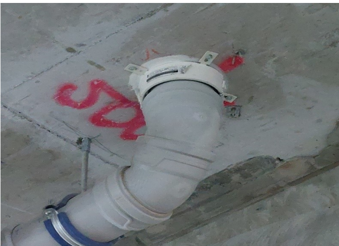
Kuva 4. Palomansetti asennettuna viemäriputkeen.
