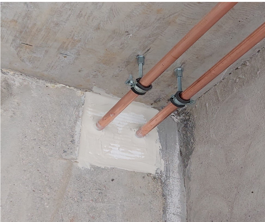
Kuva 2. Palovillan ja palosuojajannoituksen yhdistelmä putkiläpiviennissä.
