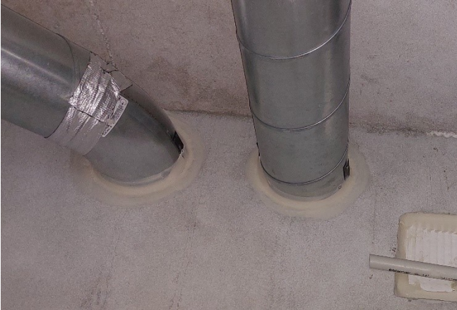
Kuva 7. Elementtihormin ja IV-putken liitos tiivistettynä palokatkomassalla.
