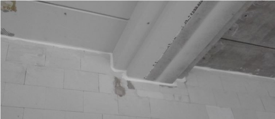
Kuvio 6. Muuratun väliseinän ja ontelolaattarakenteisen välipohjan välinen sauma tiivistettynä palokatkomassalla (Suomen Palokatko yhdistys, 2019, s. 20).
