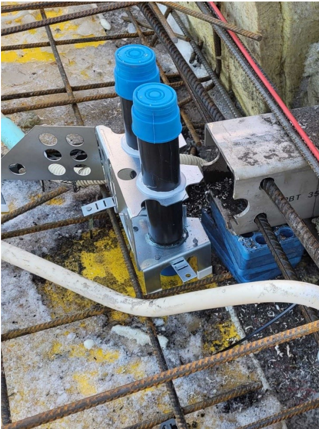
Kuva 5. Sewatek-valmisläpivienti asennettuna holvivaluun.
