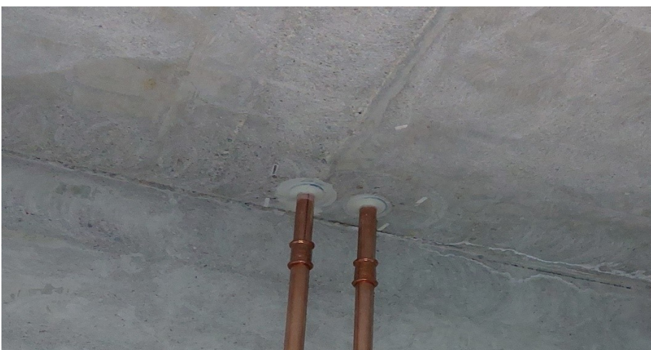
Kuva 1. Putkiläpiviennit viimeisteltynä akryylipohjaisella palokatkomassalla.
