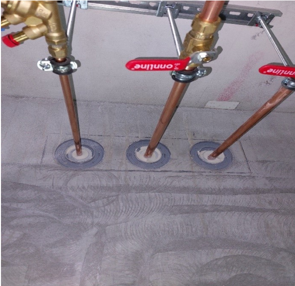
Kuva 6. Vesiputkien läpivientien palokatko toteutettuna valmisosaläpivienneillä massiiviväli-seinärakenteessa.
