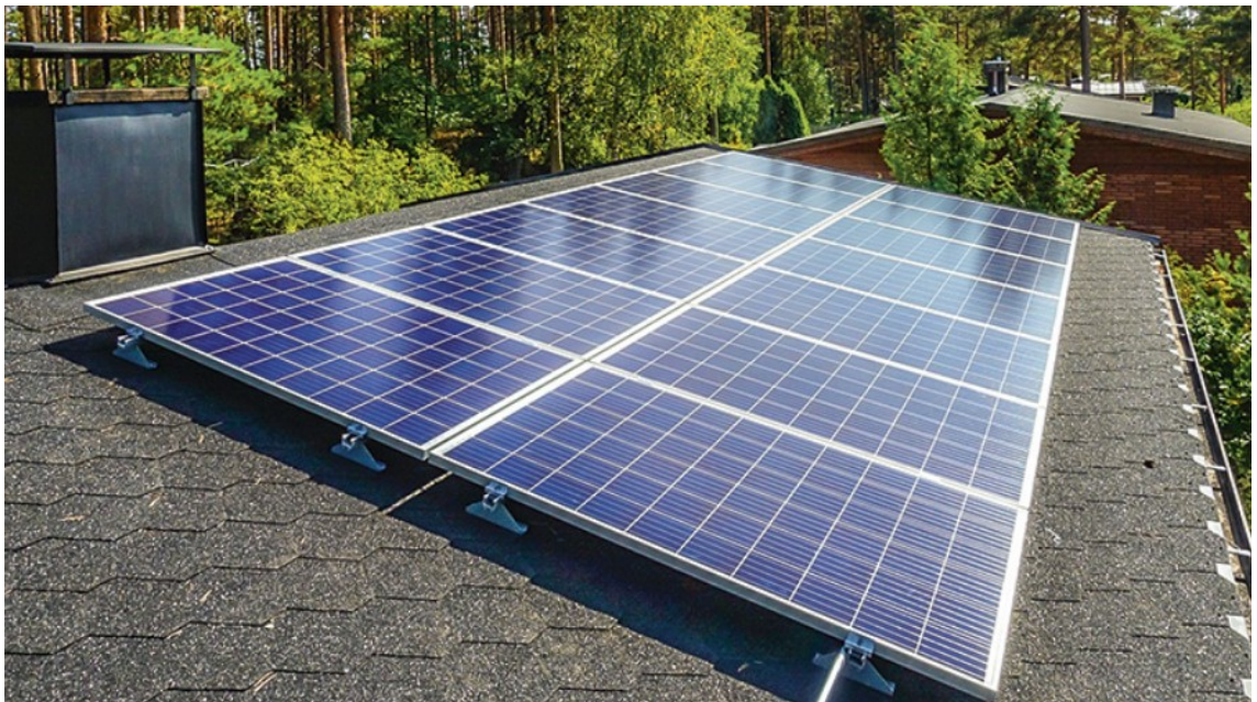
Kuva 6. Esimerkki asennetuista paneeleista huopakatolle. (Kymenlaakson sähkö oy 2022).
