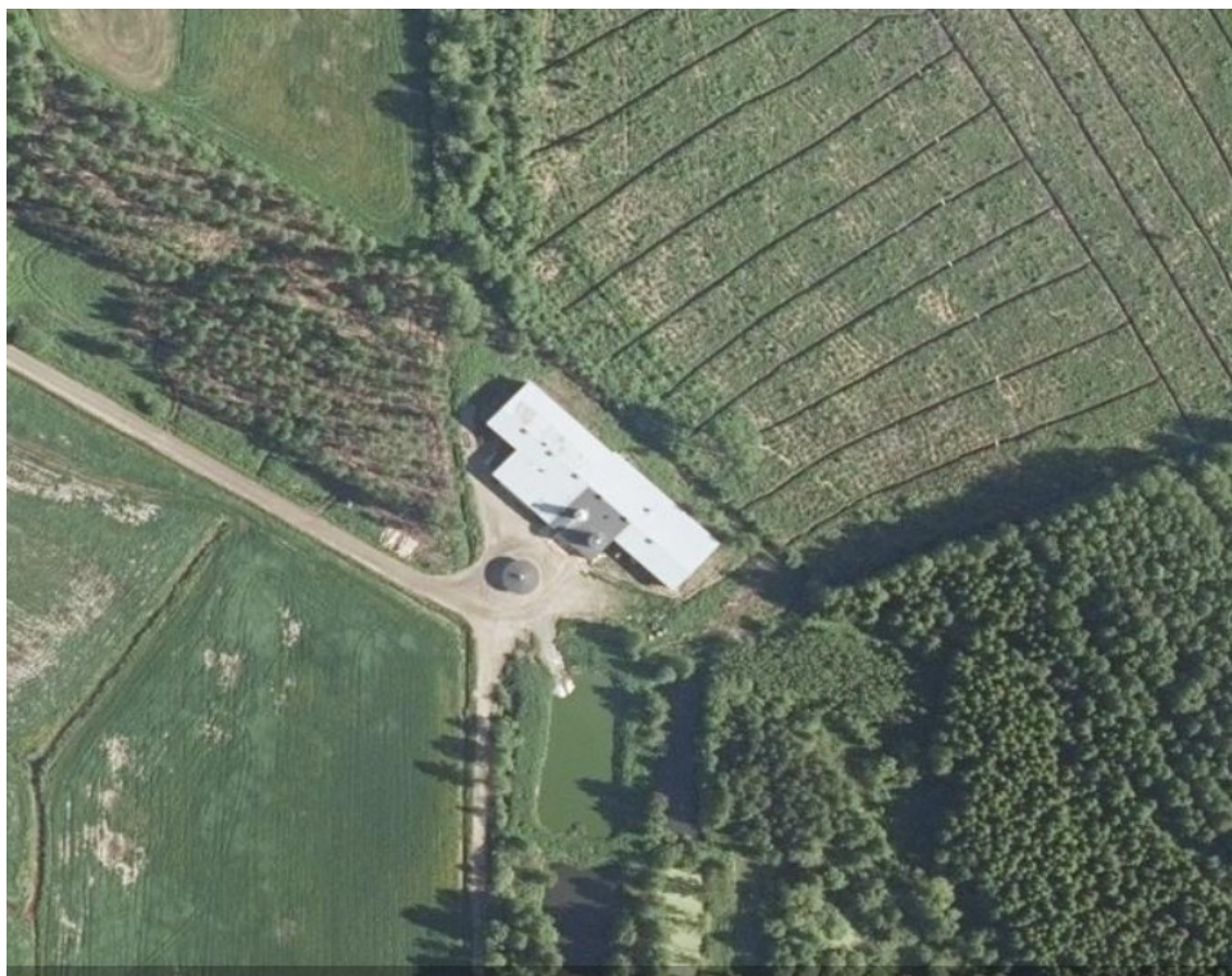
Kuva 16. Katto asennuksen varjostavia tekijöitä.
