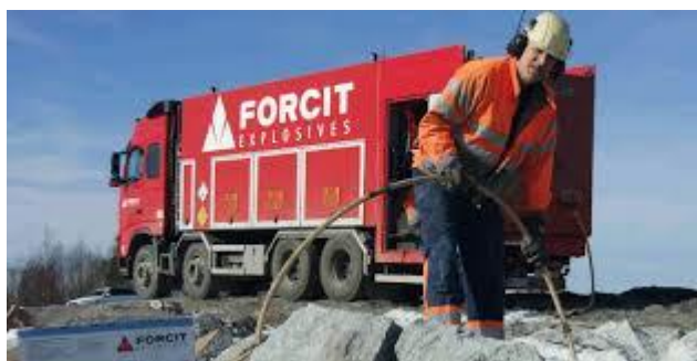
Kuva 5. Pumppuauto (Forcit Explosives www-sivut)
