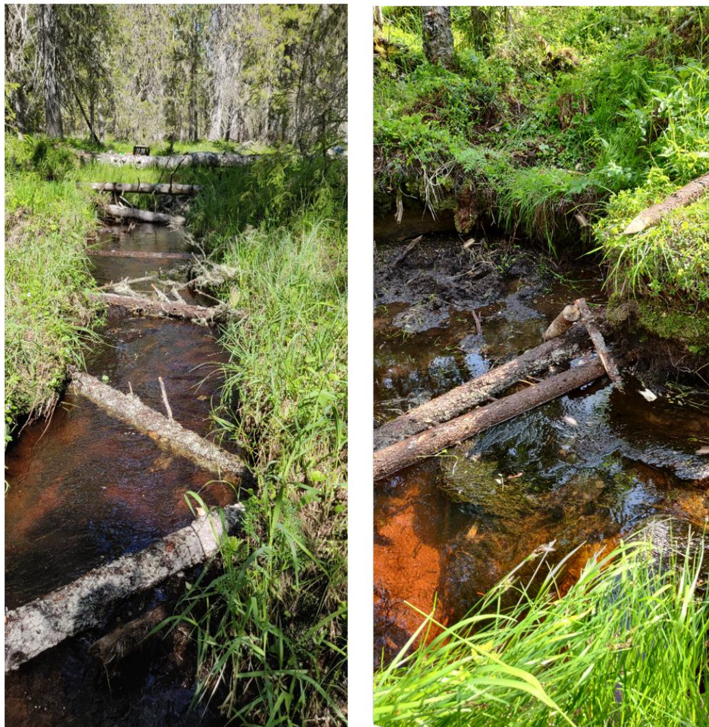
Kuva 3. Puisia virranohjureita Kumpulamminojassa Syötteen kansallispuistossa (Kuva: Saska Hovi)
