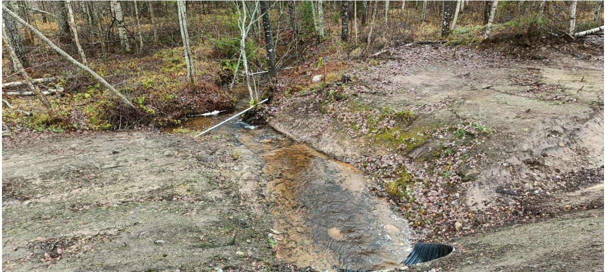
Kuva 9. Kylmäojan uoma Vanhan Nurmestien kohdalta alajuoksulle päin. Tässä kohtaa uoman yli on rakennettu uusi kevyenliikenteenväylä vuoden 2021 aikana. Tierumpu ei muodosta esteellisyyttä kalan vaellukselle (Kuva: Saska Hovi).
