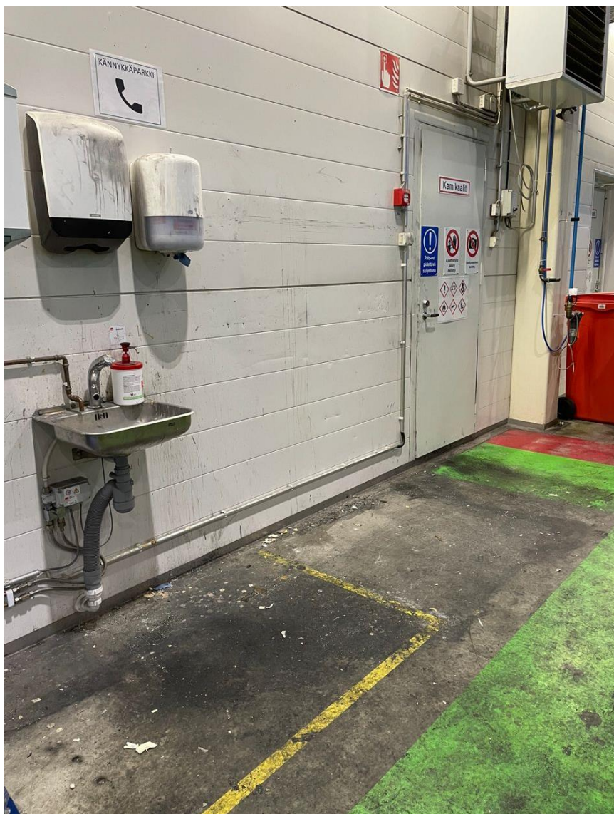
Kuva 19. Vesipiste järjestely vaiheen jälkeen.
