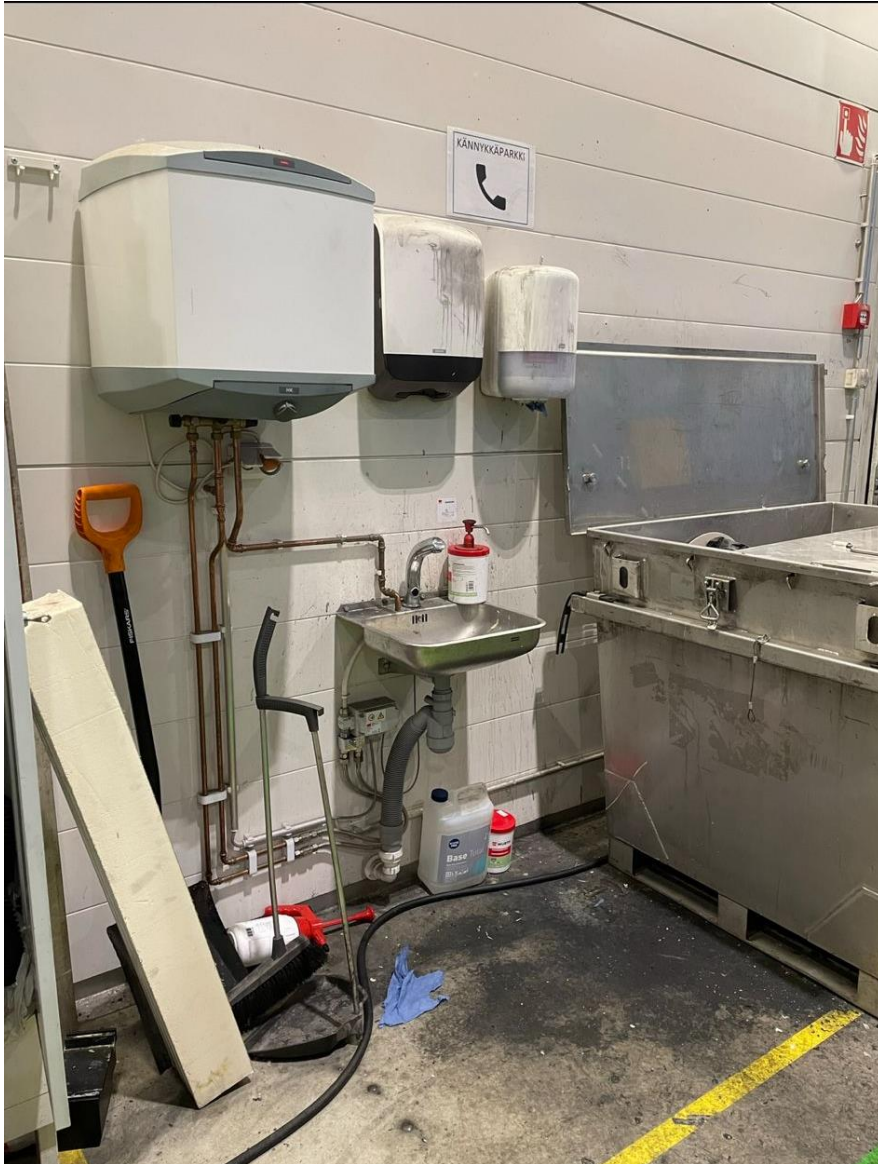
Kuva 18. Vesipiste ennen järjestelyä.
