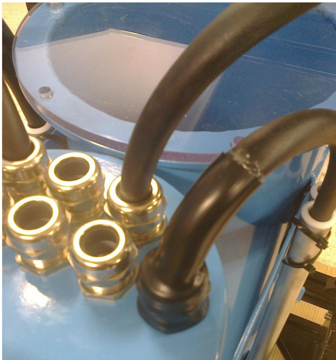
Kuva 19. Läpivientiholkkitiivistet sekä kaapelin asennuksen jälkeinen tiivistys
