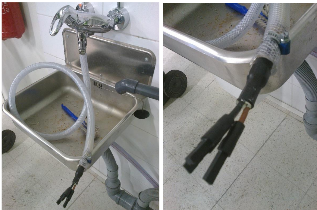
Kuva 40. Kuvakokoelma potkurilaitteiden jännitteensyöttö kaapelien tiiviyden testaus.
