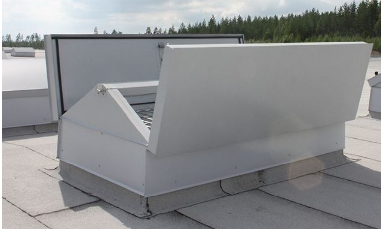
Kuva 8. Savunpoistoluukku katolla. (Keravent Oy 2022.)
