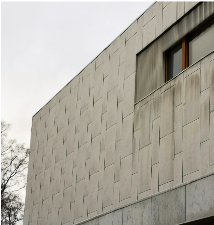
KUVA 13. Finlandia-talon käyristyneet julkisivulaatat.
