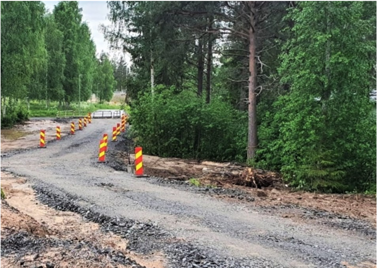
KUVA 2. Kielikeskuksen laatutietä rakennetaan maltillisesti mutta kunnianhimoisesti. (Kuva: Sanna Granroth)
