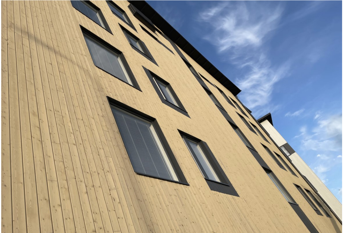
KUVA 8. Kerrostalon ulkoverhouspaneeli Tampereella (Vladimir Vahvijainen 2022)
