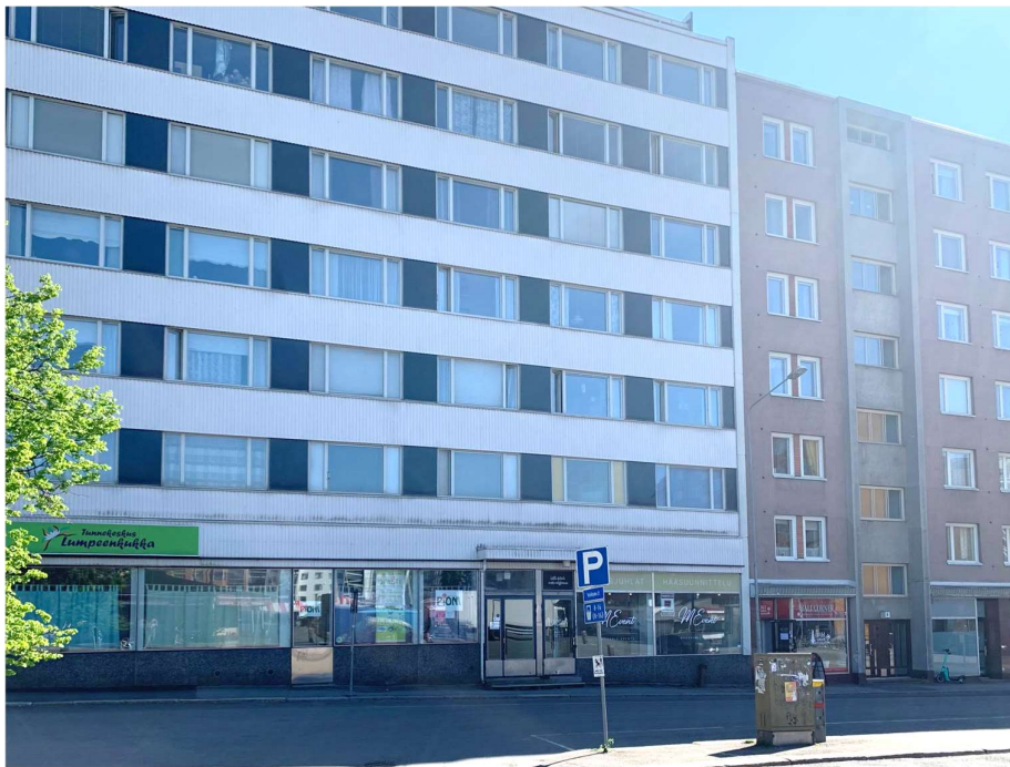
KUVA 45. Korttelin nykyiset rakennukset Tammelantorilta päin kuvattuna
