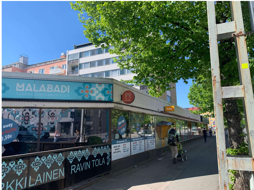
KUVA 44. Purettava yksikerroksinen liikerakennus Tammelan puistokadun ja Vellamonkadun risteyksestä kuvattuna
