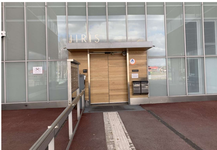
KUVA 27. Sisäänkäynti Iiris-keskukseen Helsingissä, normaalin näkökyvyn kautta saatu näkymä.
