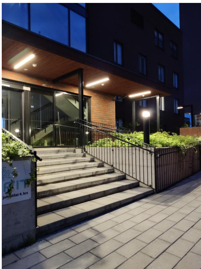
KUVA 12. Katokseen upotetut modernit valaisimet tuovat riittävästi valoa sisäänkäynnille ja portaiden viereen sijoitettu pollari parantaa portaiden näkyvyyttä (Kranni 2022)
