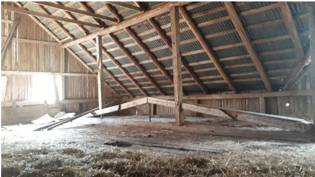
KUVA 36. Välipohjan suuren jännevälin ylityspalkki. (Henriksson, J. 2022)
