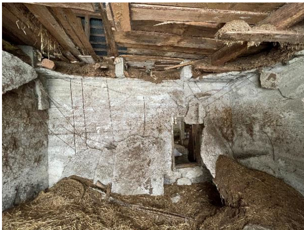
KUVA 35. Välipohjan betonipalkkirakenne näkyvillä lantalassa. (Henriksson, J. 2022)
