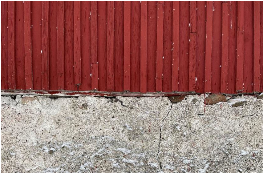
KUVA 32. Julkisivun ohut pystyrimotus. (Henriksson, J. 2022)
