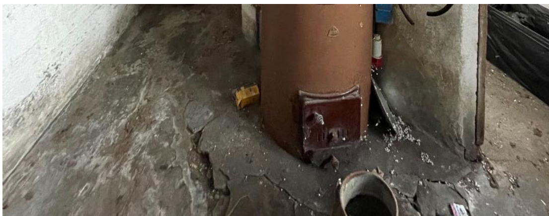
KUVA 29. Navetan betonilattia. (Henriksson, J. 2022)
