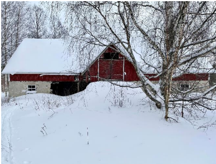
KUVA 19. Navettarakennuksen kivijulkisivu ja käynti vintille. (Henriksson, J. 2022)
