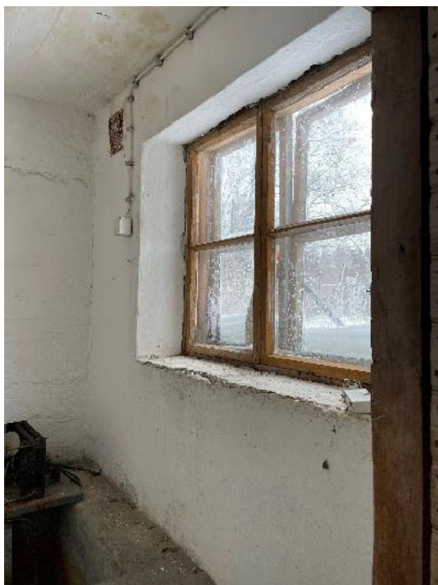
KUVA 40. Maantasokerroksen ikkuna rakennuksen sisäpuolelta. (Henriksson, J. 2022)
