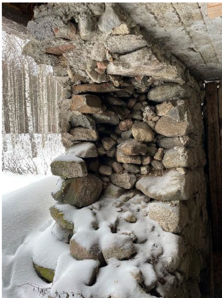
KUVA 31. Ulkoseinän kivimuurirakenne. (Henriksson, J. 2022)
