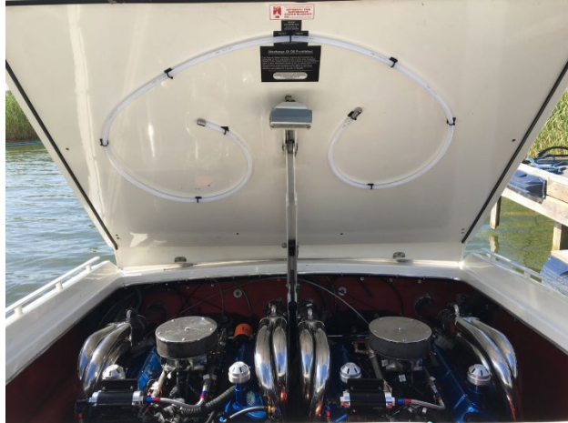
Kuva 13. Kuvassa Blazecut asennettuna konetilan kanteen (Blazecut 2022).
