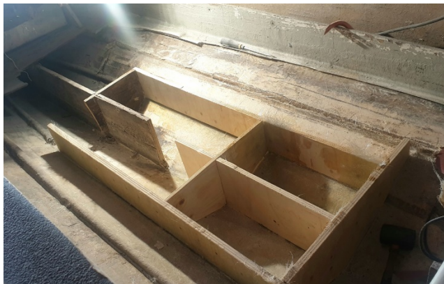
Kuva 16. Uudet pitkittäis- ja poikittaisjäykisteet.
