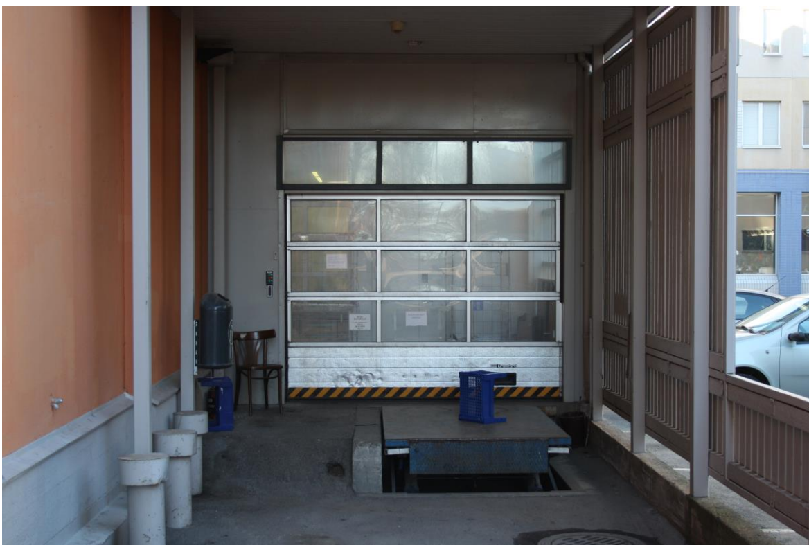
Figur 12. Lastbryggan som tjänstgör företagen i byggnaden.
