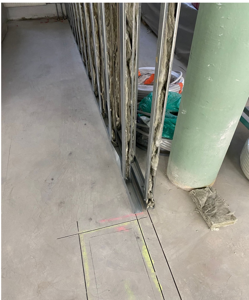
Kuva 7. Väliseinän rangoitus Slimwall tekniikassa. (14)
