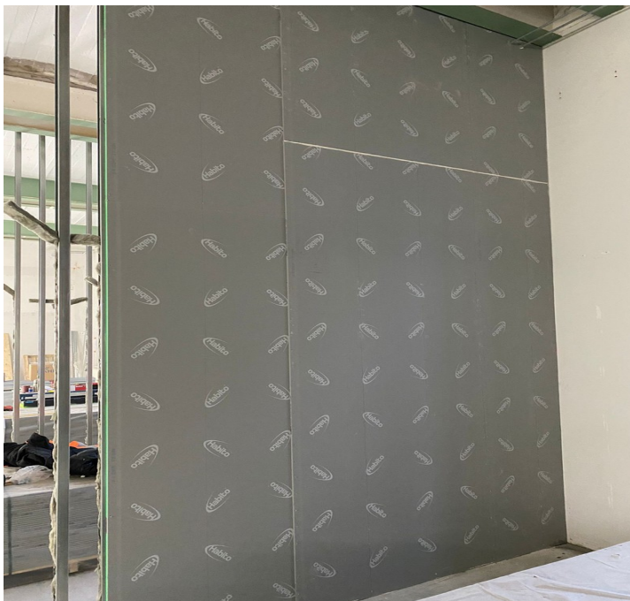
Kuva 8. Habito-levy työmaalla Tampereella (10)
