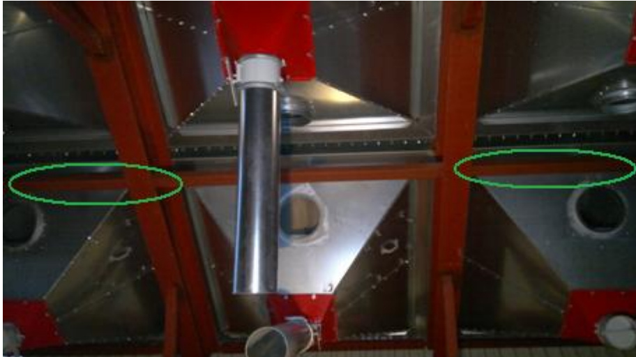
Kuva 50. Loisteputkivalaisimet asennetaan kuvaan merkittyihin paikkoihin
