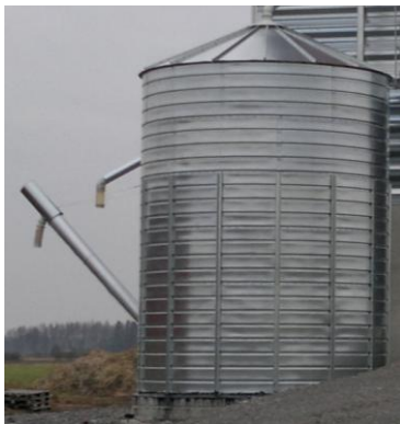
Kuva 41. Kuivaamon pyörösiilo jossa on säältä suojattu viljaruuvi
