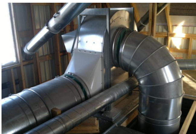
Kuva 35. Ylätasanteelle asennettu järeä imuri
