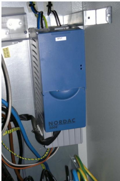
Kuva 39. Syöttölaitteen moottoria ohjaava taajuusmuuttaja
