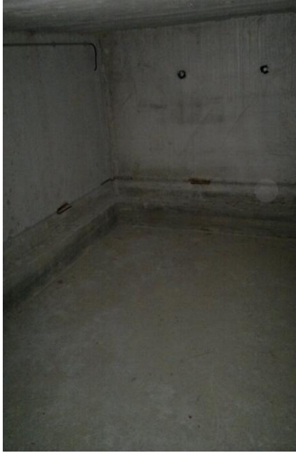
Kuva 51. Vastaanoton alapuolella oleva lisähuone
