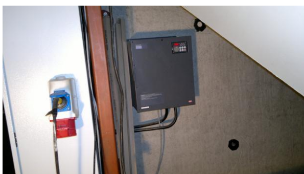
Kuva 37. Imurin moottoria ohjaava taajuusmuuttaja
