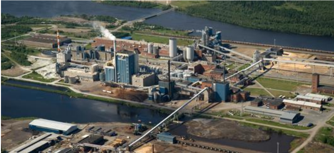
Kuva 9. Pajusaaren tehtaat. (Metsä Fibre, www-sivut, hakupäivä 11.2.2014.)
