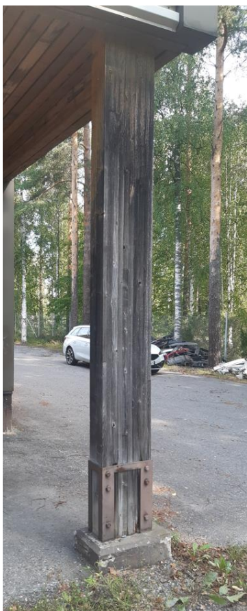
Kuva 45. Pilari ulkona, katoksessa (Keijo Pellikka 2022).
