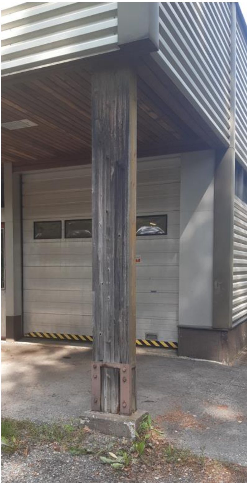
Kuva 46. Pilari ulkona, katoksessa (Keijo Pellikka 2022).
