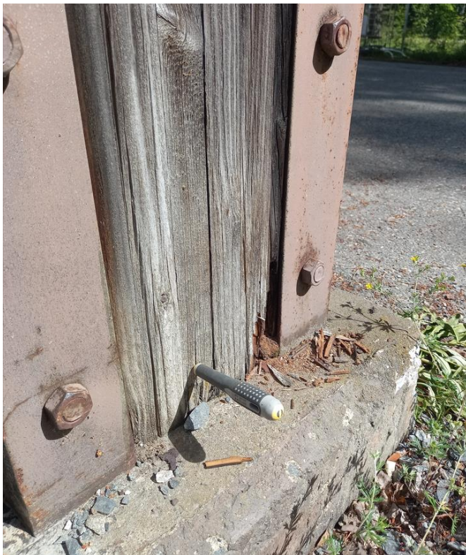
Kuva 47. Lahopiikki upotettuna pilariin (Heli Rautiainen 2022).
