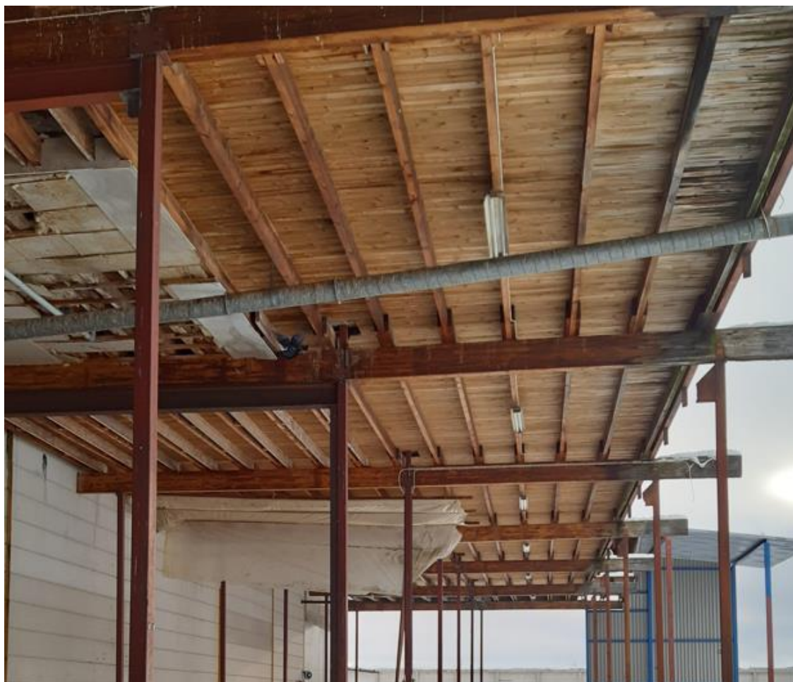
Kuva 54. Liimapuurakenteet vaativat tutkimuksia ennen uusiokäyttöä (Keijo Pellikka).
