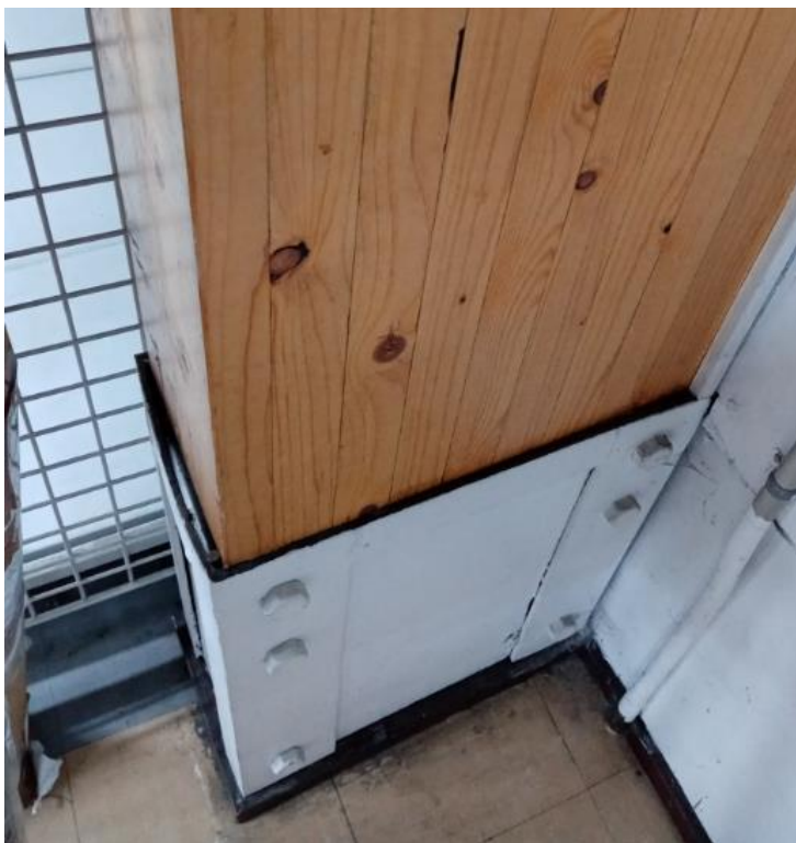
Kuva 41. Pilarin liitos perustukseen (Keijo Pellikka 2022).
