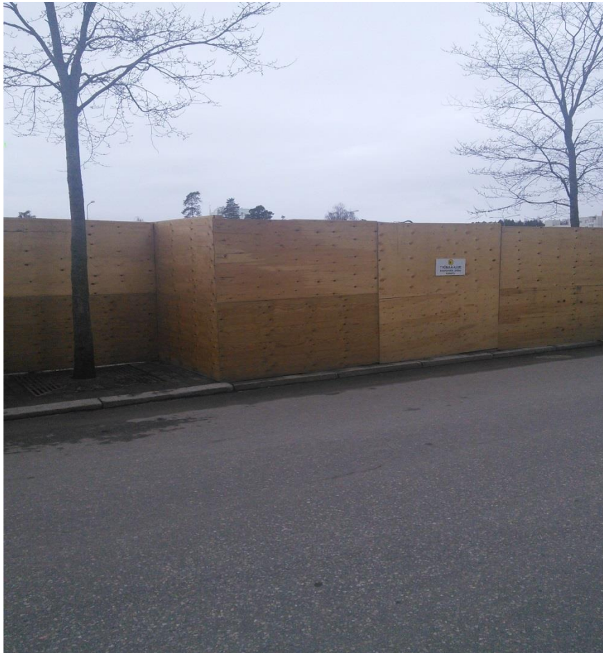
Kuva 5. Malliesimerkki yleisen alueen rajaamisesta työmaa-alueeksi (Miikka Sireni, Helsingin kaupunki).
