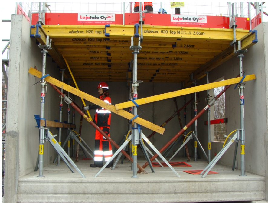
KUVA 6. Perustus ja runkorakentamisen rasti
