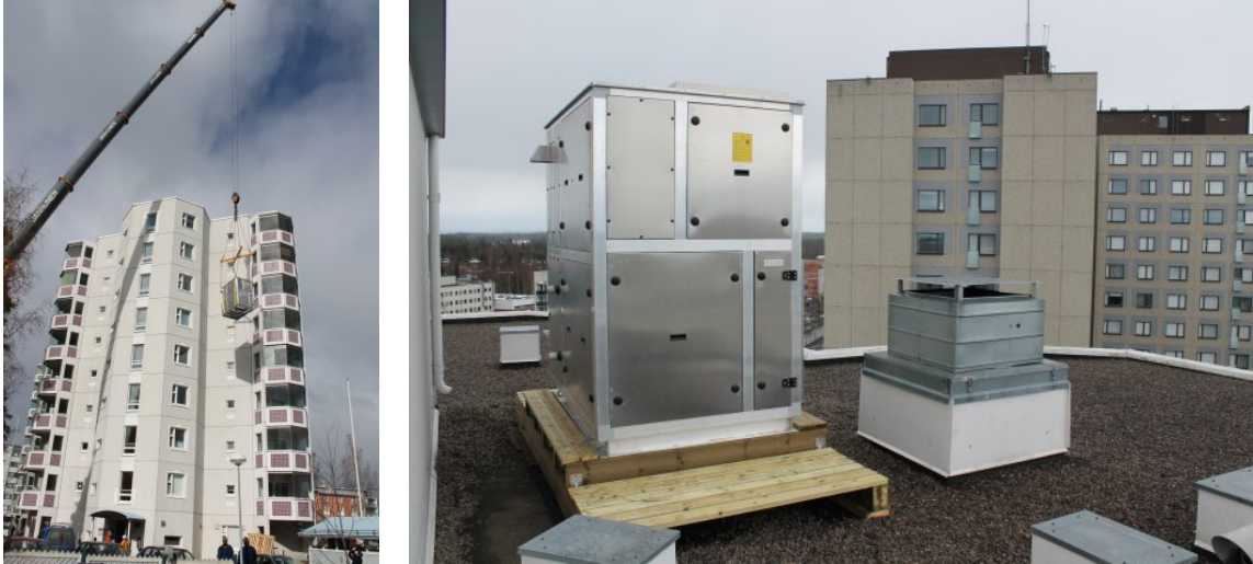
Kuva 26. Vasemmalla, laitteiston nosto katolle. Oikealla, laitteisto katolla. [40]
