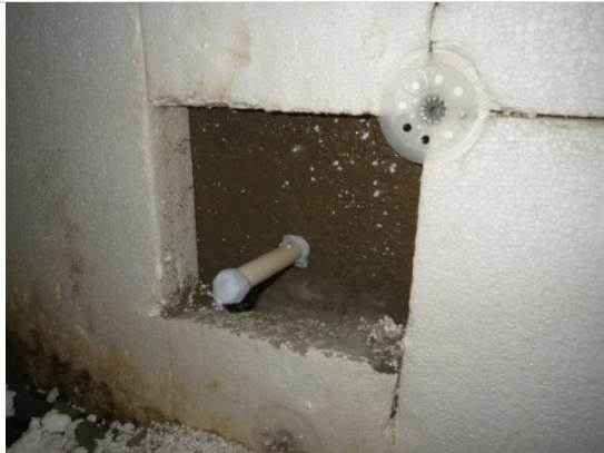
Kuva 35. RT3: Avauksen lopuksi tehty alempi porareikä.
