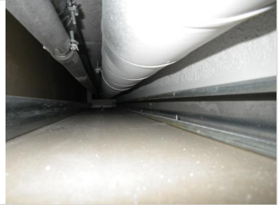
Kuva 14. RT2: yleiskuva putkikotelon sisältä.
