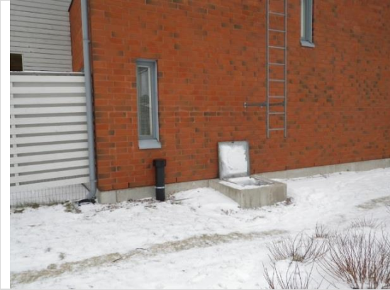
Kuva 15. Yleiskuva alapohjan ryömintätilan tarkastusluukusta huoneiston G 34 päädissä.
