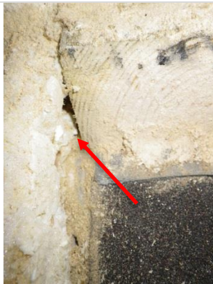
Kuva 9. RT1: lähikuva alapohjarakenteesta (vasemmalla) ja alaohjauspuusta. Rakenteiden välissä oleva rako jatkuu alapohjan tuletustilaan asti.
