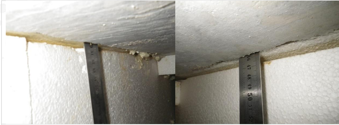
Kuva 37. Huoneiston G 39 kohdalla sokkelin eristelevyn ja ontelolaatan välisen raon syvyydeksi tuli noin 500 mm.
