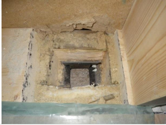
Kuva 7. RT1: alajuoksu ja sen alapuolinen rakenne sokkelin pintaan asti.
