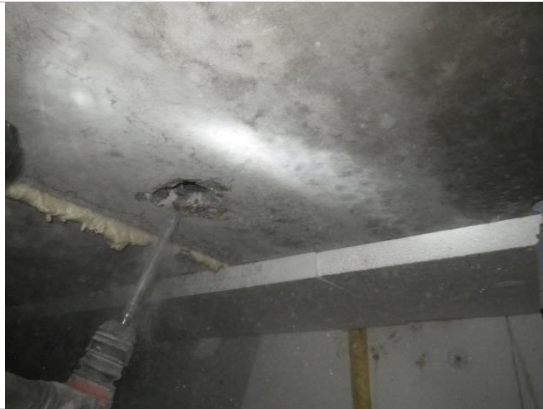
Kuva 45. Ontelolaatan avauskohta huoneiston G40 ruokatilán alapuolella.
