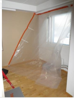
Kuva 1. RT1: yleiskuva rakenteen avauskohdasta.
