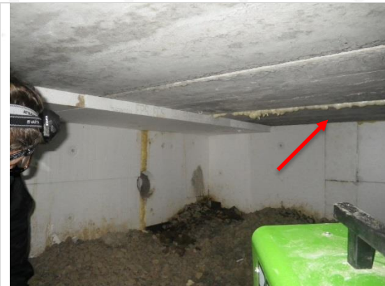
Kuva 27. RT3: yleiskuva avauspaikasta. Avas tehtiin nuolen kohdalta.
