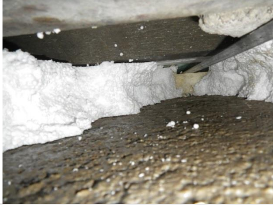
Kuva 33. RT3: teräsmitta asetettuna höyrynsulkua vasten.
