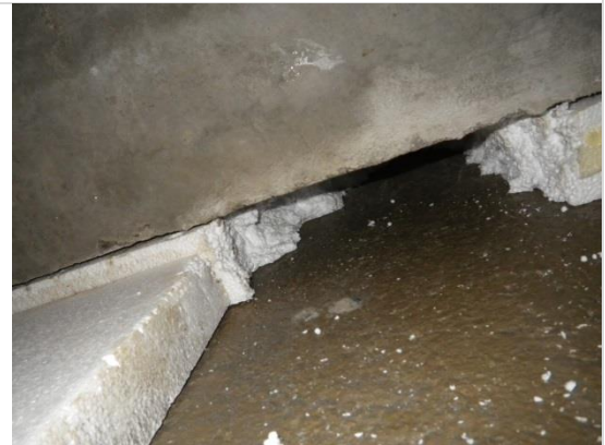
Kuva 30. RT3: eristelevyä on poistettu avauskohdasta.
