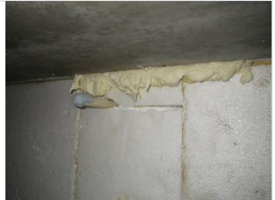
Kuva 36. RT3: Avauksen lopuksi tehty ylempi porareikä. Rakenneavauskohta tiivistettiin uretaanivaahdolla.
