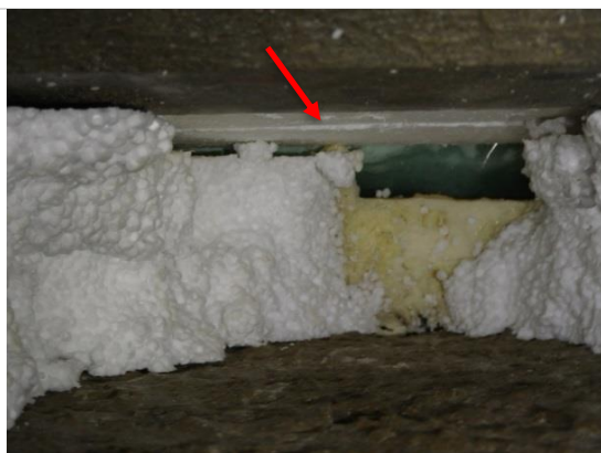
Kuva 31. RT3: eristelevy ja ilmarako jatkuvat alaohjauspuuhun asti. Nuolen kohdalla näkyy alapohjan lämmöneristekerros.
