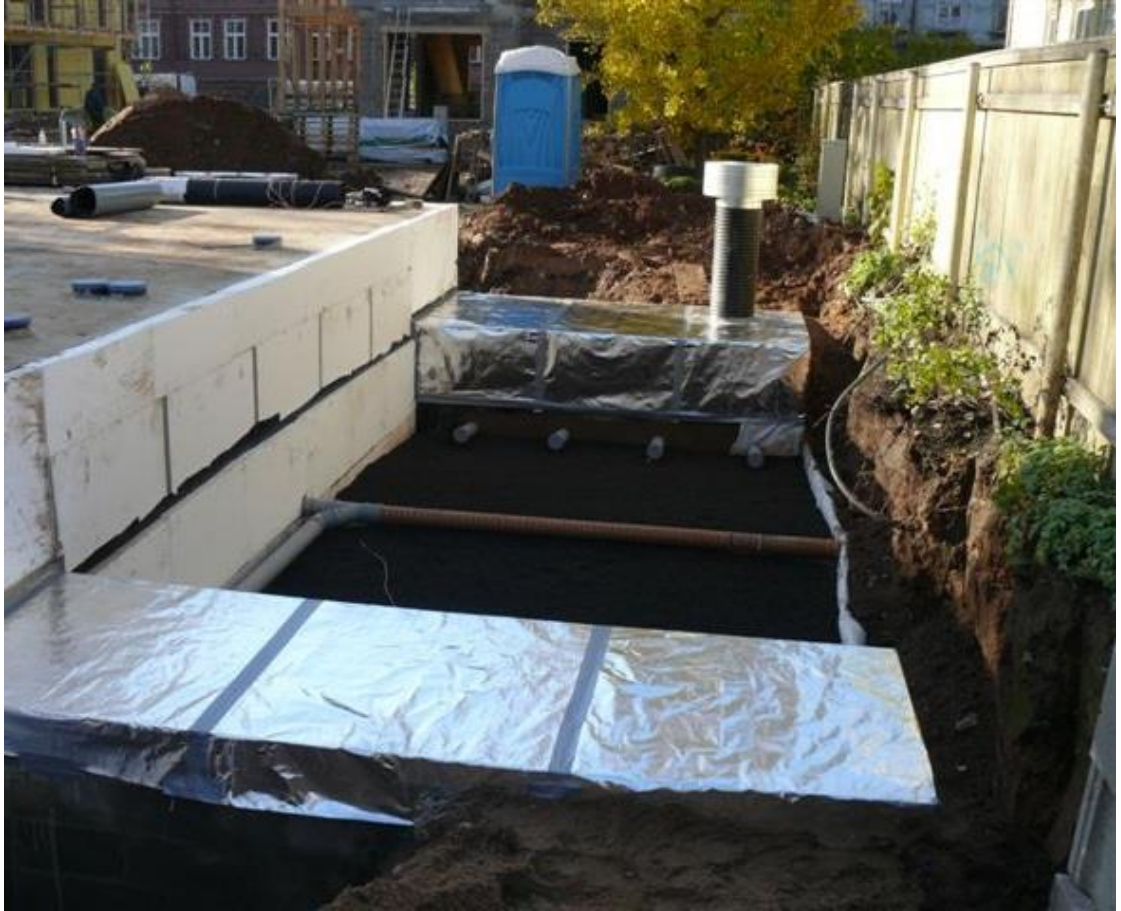
Liite 4. Maalämpövarasto maanrakennusvaiheessa
