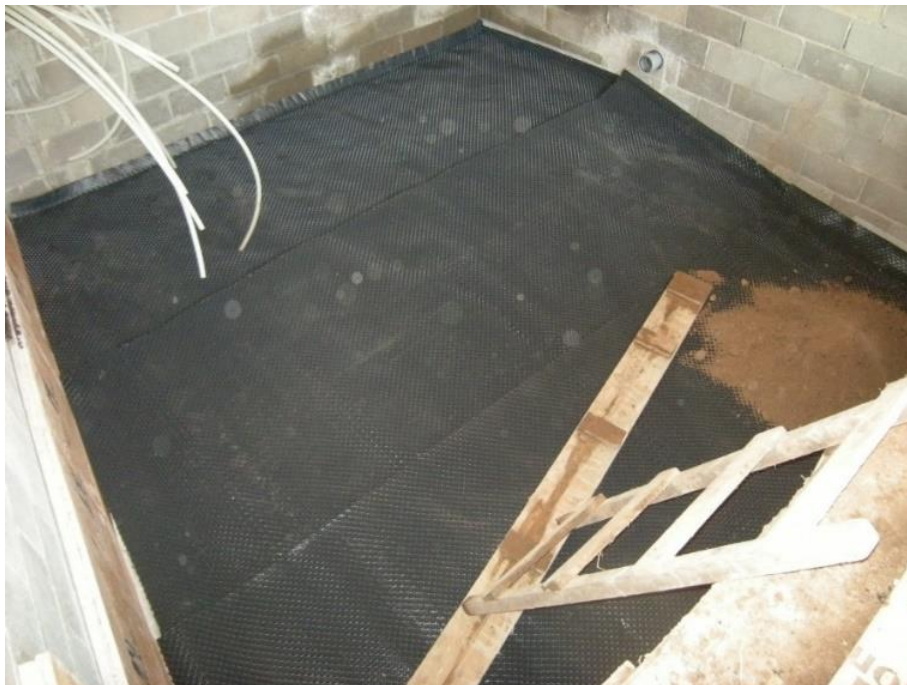
Kuvio 9. Kevytsoran eristäminen patolevyllä.
