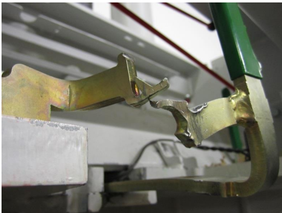
Kuva 5 Oikeanpuolinen metallilangan asennusmieikka
