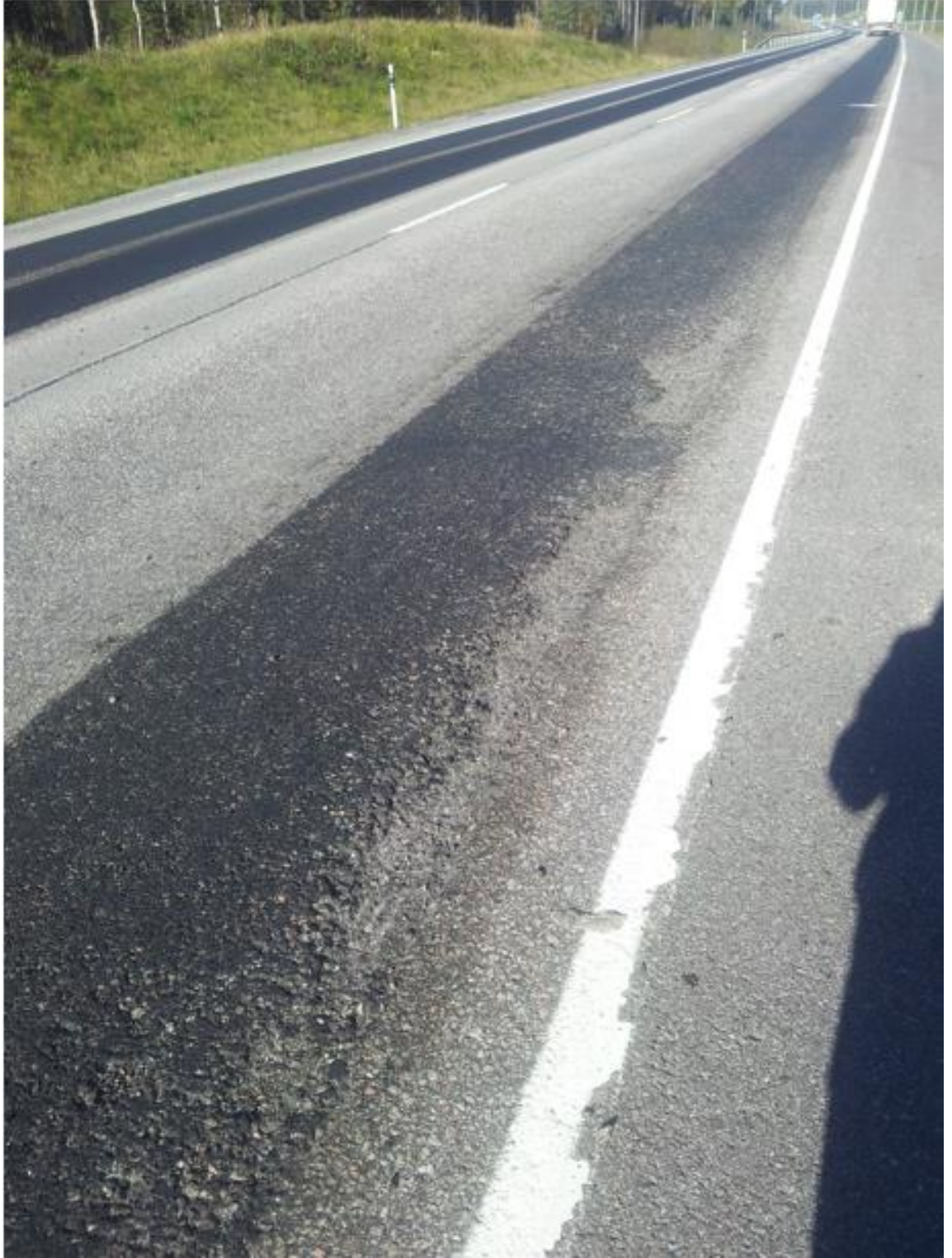
Kuva 2. Huonon sääolosuhteen aikana työskentelyn aiheuttama purkauma. (kuva Joonas Sepänen)
