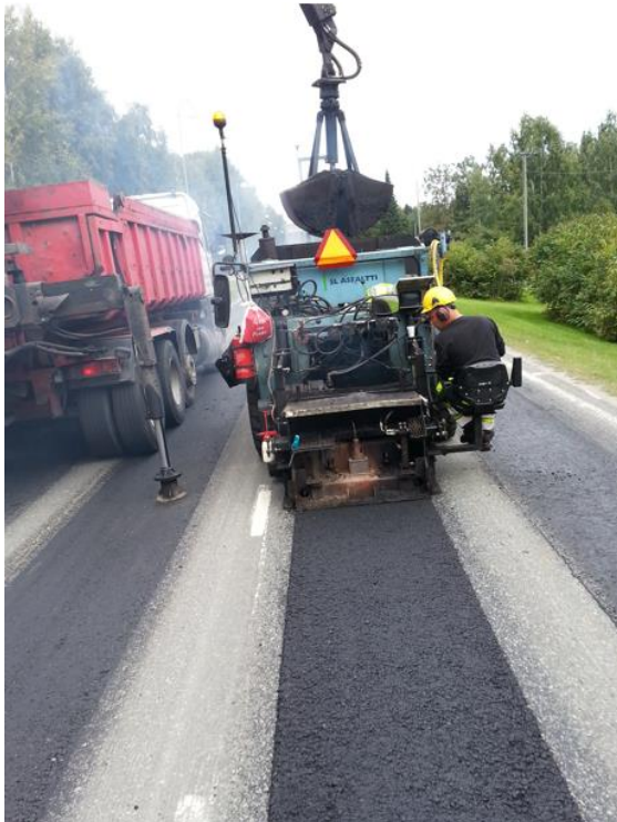
Kuva 7. Massan lisäys koneen liikkeessä (Kuva Iris Mietinen).
