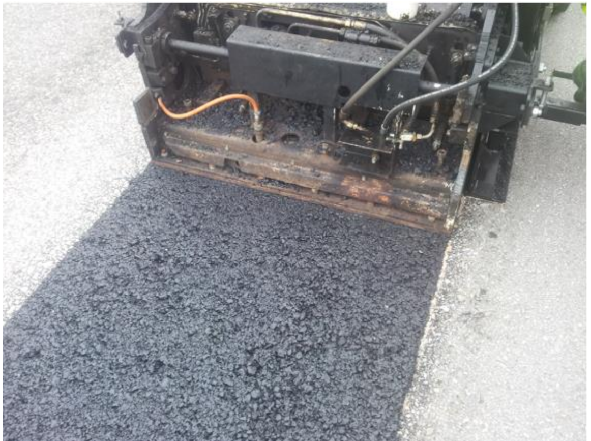
Kuva 8. Uraremixerin levittämää massaa jyrsittyyn laatikkoon. (Kuva Joonas Seppänen)
