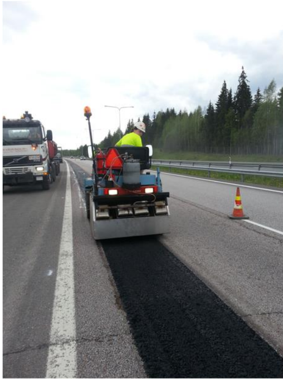
Kuva 10. Urapaikkauksen jyrääminen.(Kuva Joonas Seppänen).
