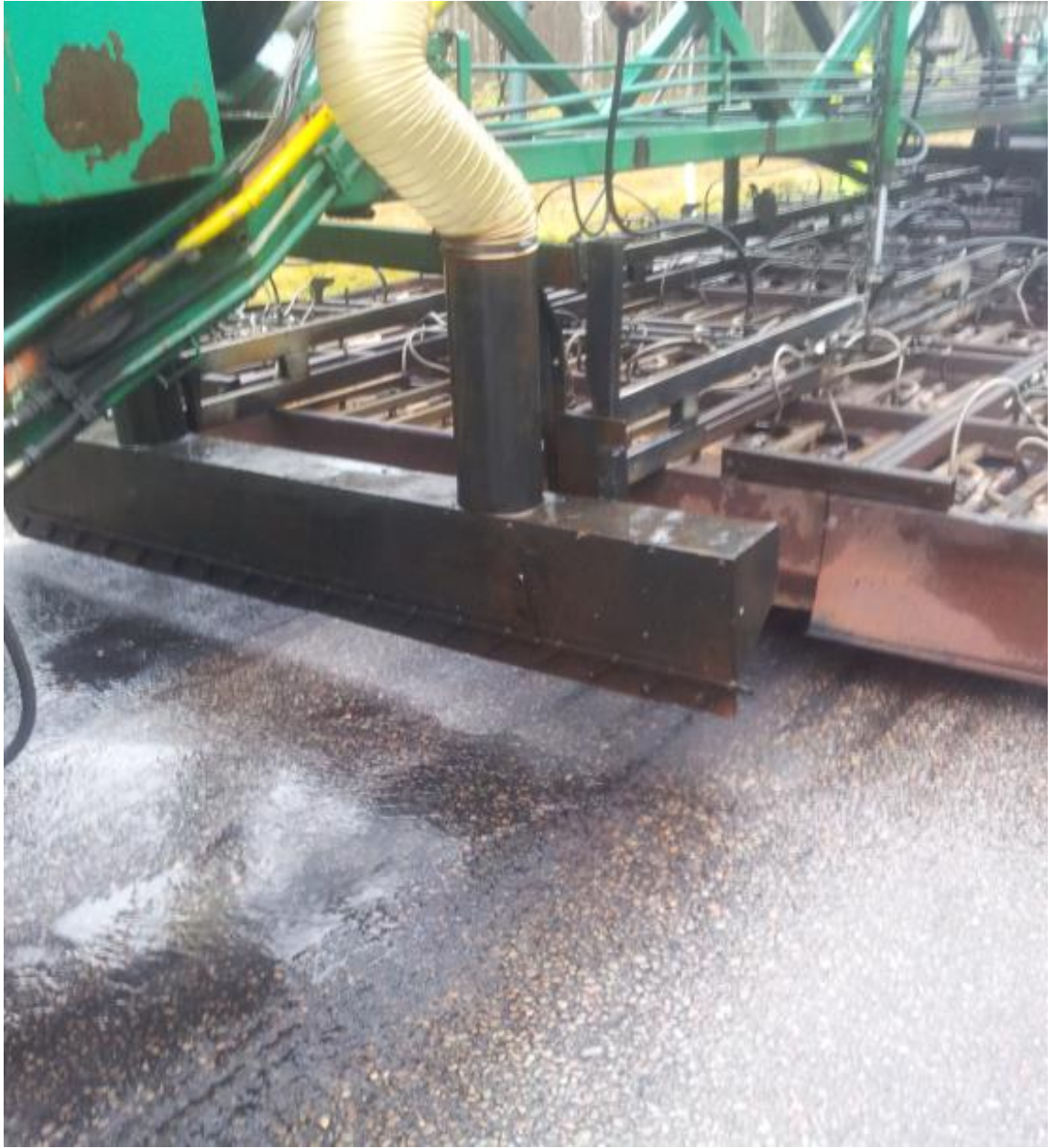
Kuva 12. Remixer-menetelmässä käytettävä esilämmittimen puhallinlaite. (Kuva Joonas Seppänen)
