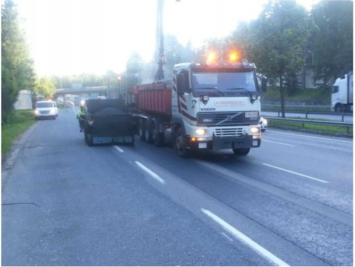
Kuva 6. Lisämassin täyttö koneen ollessa paikallaan.(Kuva Iris Mietinen).
