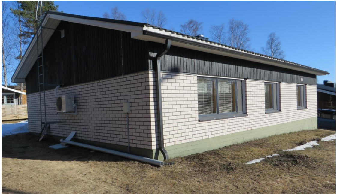
Kuva 20. Lattiapinnan korkeusasema on samassa korkeudessa lähimpänä näkyvän rakennuksen kulman kanssa. Alaohjauspuun korkeusasema kyseisessä kohteessa on n. 50–100 mm lattian pintaa alempana.
