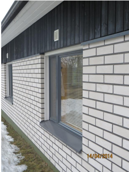
Kuva 27. Esimerkkikohteeseen on uusittu ikkunat ja vesipellitykset.
