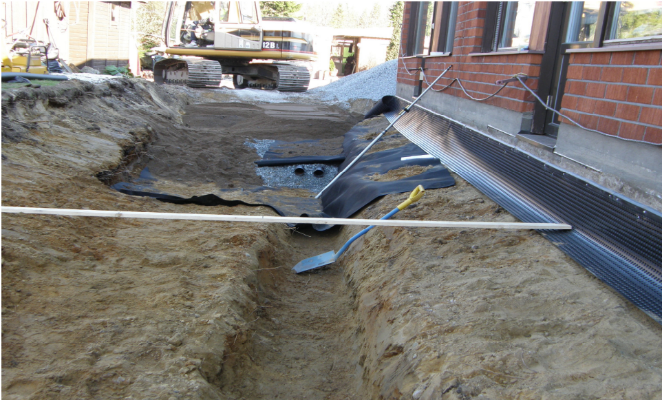
Kuva 5. Suodatinkankaan asennuksen tarkoituksena oli estää eri maalajien sekoittuminen keskenään.
