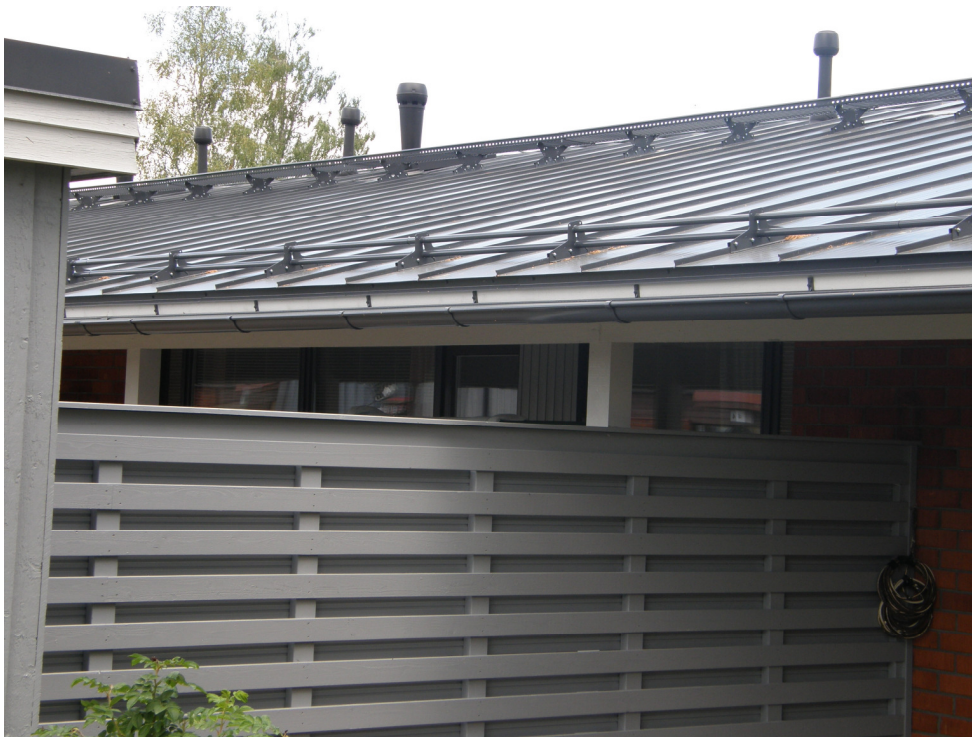
Kuva 13. Konesaumattu peltikattoasennus on metallialan ammattilaisten työtä.
