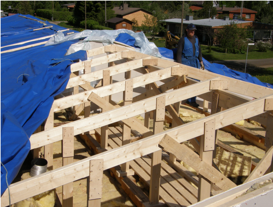
Kuva 12. Suojauksessa käytimme isoja 6 x 9 metriä olevia pressuja.
