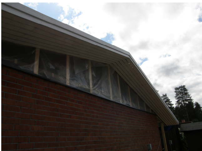
Kuva 23. Rakennusaikainen kosteussuojaus oli tärkeää koska ilmassa on tuulen mukana kulkeutuvaa kosteutta.
