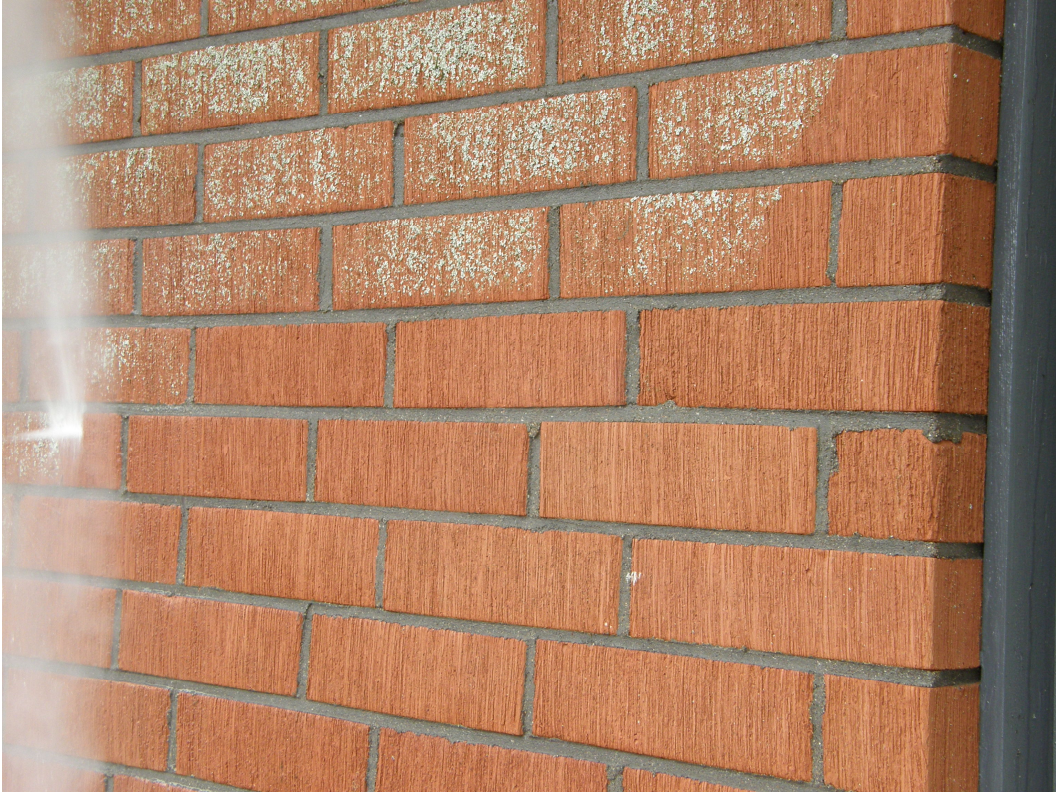
Kuva 19. Tehokas ja ympäristöystävällinen tiilipintojen puhdistustapa oli kuumavesipuhdistus.
