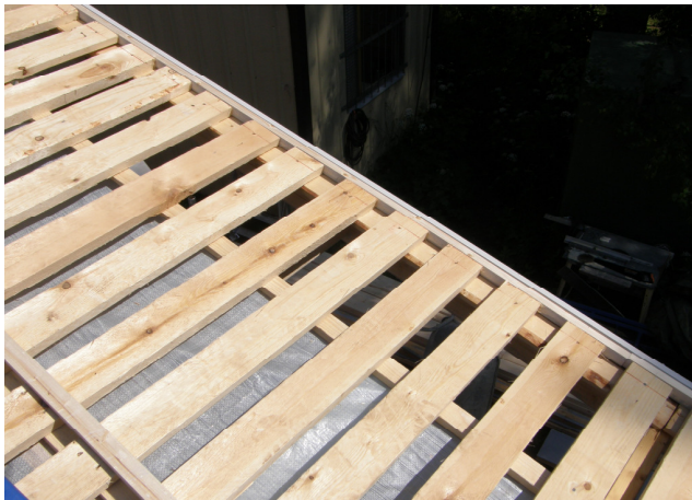
Kuva 24. Aluskatteen asennussuunnitelmassa rajaukset viedään räystäälle asti.
