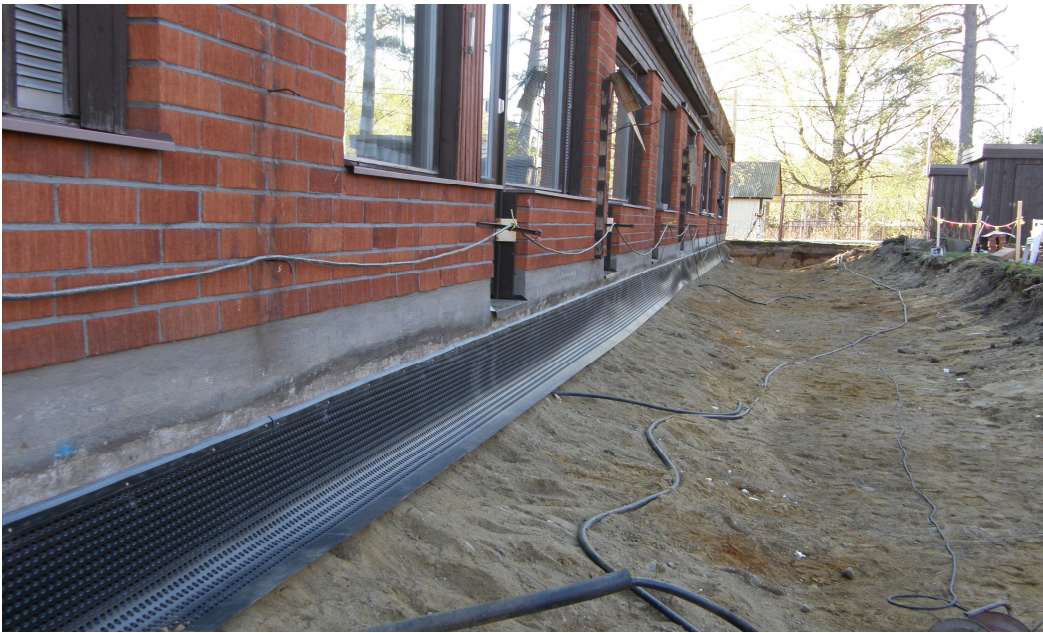
Kuva 4. Teimme päätöksen kaivaa pitkittäin kulkevat kaapelit esiin ja jos johdoissa olisi tarpeeksi pituutta, voisimme siirtää kaapelit työajaksi kaivannon sivuun.
