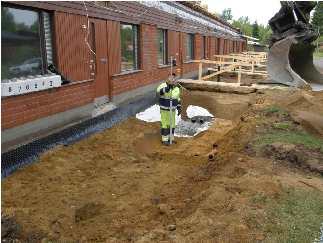
Kuva 7. Huoneistoihin vapaa pääsy oli turvattava koko kaivu- ja rakennustyöajan.
