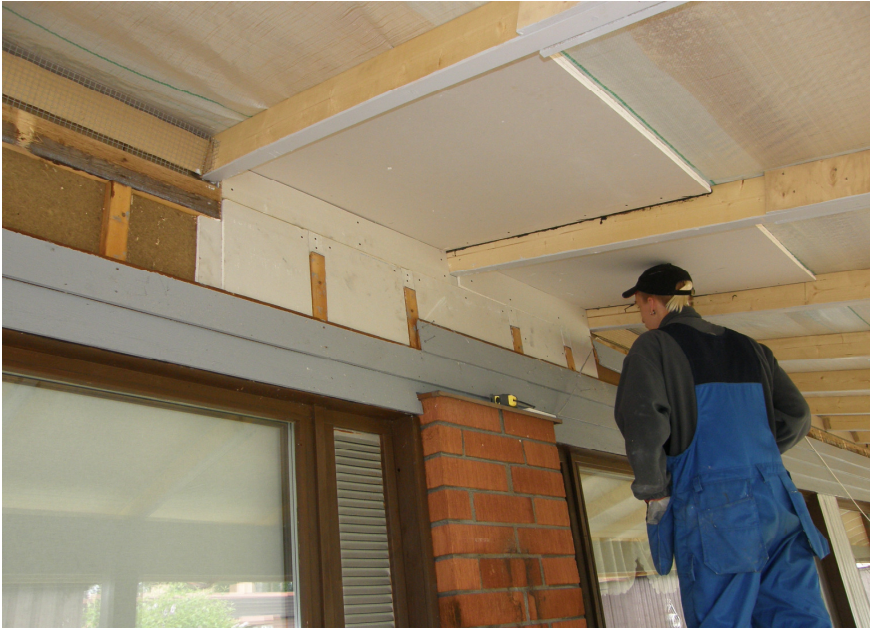
Kuva 18. Ulkoseiniä palokatkot olivat melko hankalia tehdä, koska niiden oli laskeuduttava räystäään alaosasta ikkunan yläosaan saakka.
