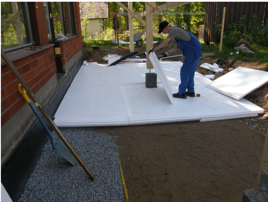
Kuva 21. Kun kattorakenteet olivat paikoillaan, alkoivat rakennuksen taakanverannan eristystyöt.
