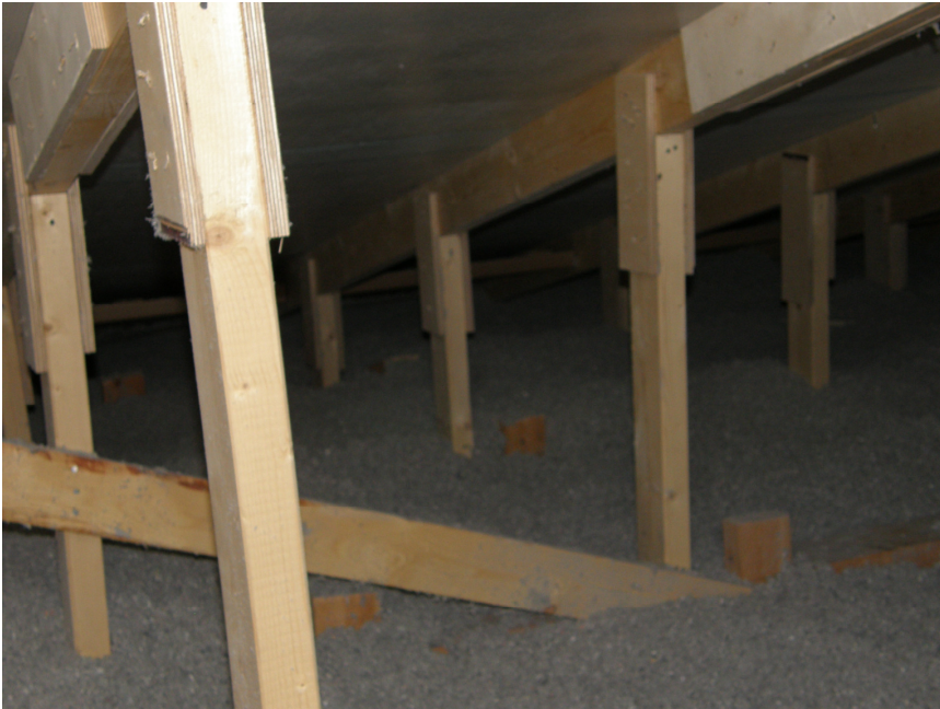
Kuva 15. Valmista puhallusvillauullakkoa.
