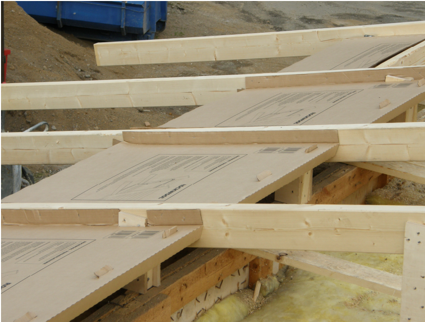
Kuva 17. Tuulenhjaimet asennettuna.
