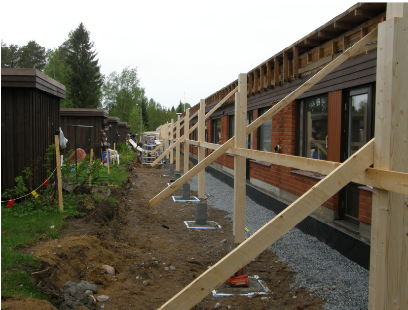
Kuva 8. Valujen kuivuttua voimme asentaa 260 x 50 mm kertopuupalkin paikoilleen mikä helpotti katon tekoa.
