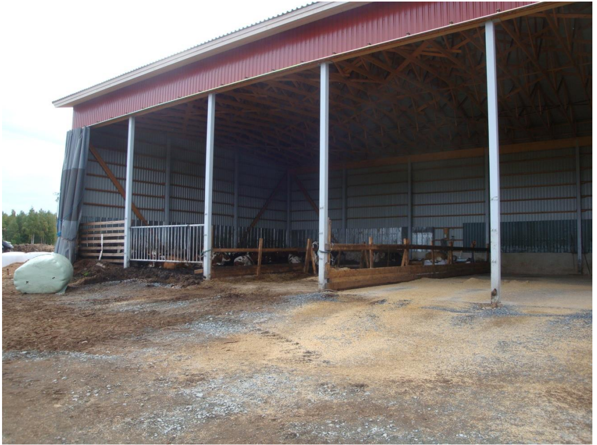
Kuva2. Rakennustyömaan vieressä rehuvarasto toimii väliaikaisena eläinsuojana, josta eläimet ovat helppo ajaa uuteen navettaan. Varastossa voi säilyttää myös rakennustarvikkeita suojassa. [8.]
