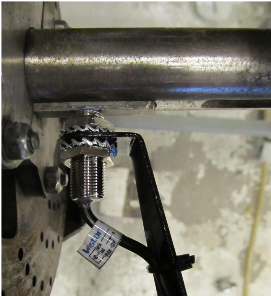
Kuva 8. Taka-akselin pyörintänopeusanturi asennettuna.
