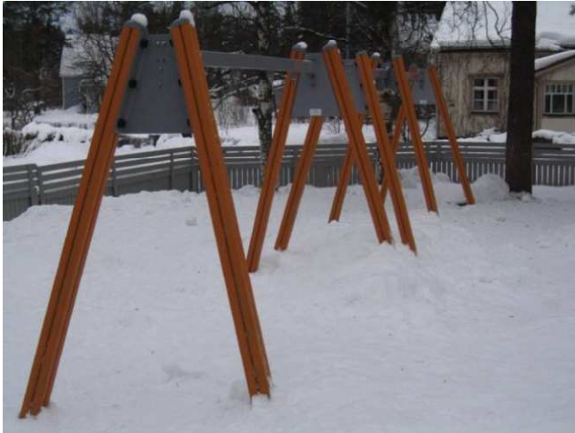
KUVA 6. Maa keinujen alla on erittäin epätasainen ja saattaisi aiheuttaa vaaratilanteen, jos keinuistuimet olisivat paikallaan. Keinuistuimen ja maanpinnan etäisyys muuttuu helposti kielletyn kokoiseksi lumen pakkaantuessa maahan. (Pouttu, P. 2011. Leikkipaikkojen talvihoito, s.25).
