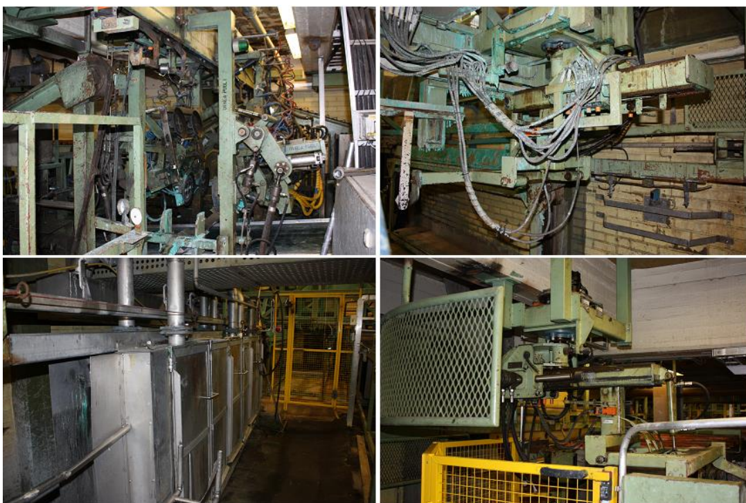
Kuva 1. Vasemmalta oikealle: strippauskone, syöttöyksikkö 1, pesuysikkö ja syöttöyksikkö 2. Kuvat Atte Hakala.
