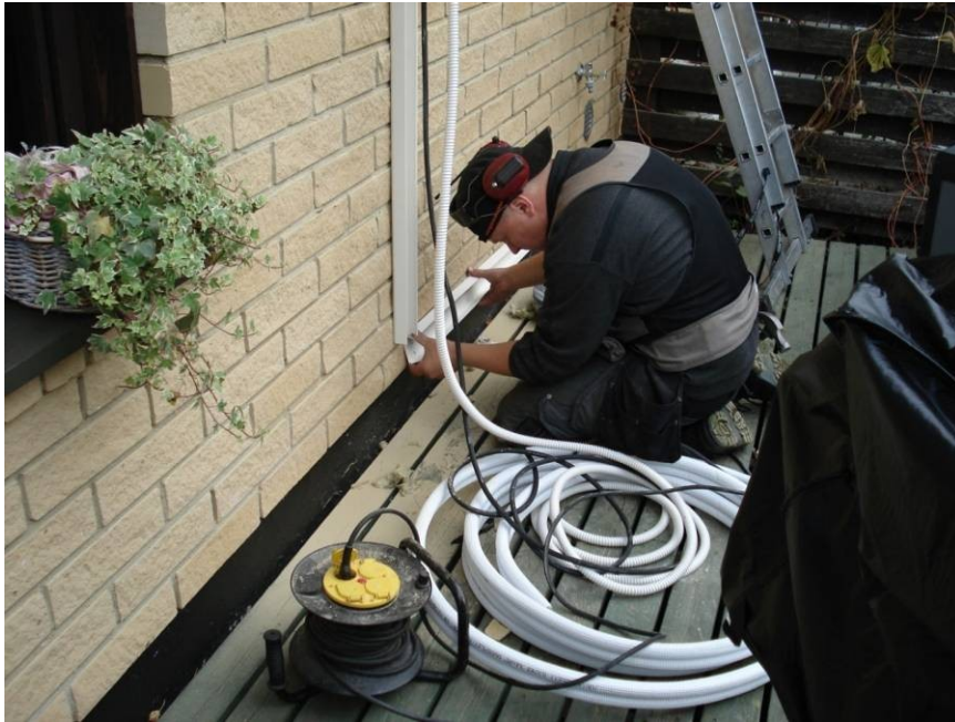
Kuva 36. Putkistojen ja sähköliitännöjen veto ja kiinnitys
