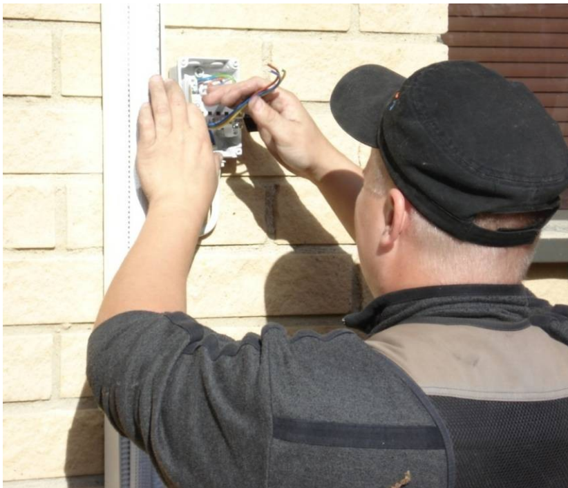
Kuva 42. Asentajan asentaa vikavirtasuojakytkimen suojaamaan ilmalämpöpump-pua
