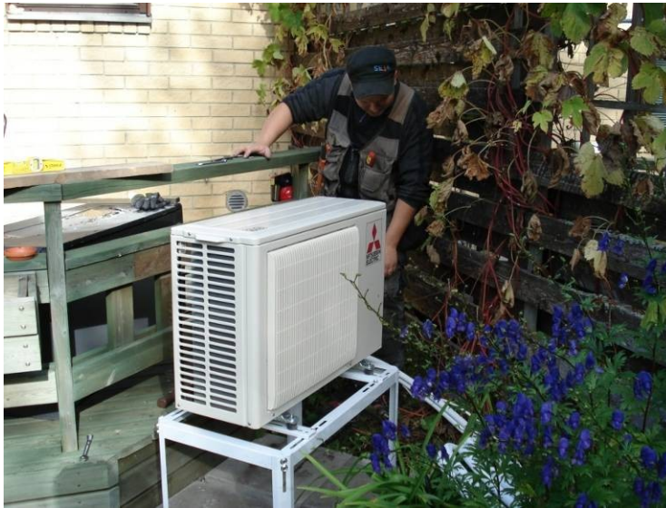
Kuva 43. Ulkoyksikön asennus maatelineen päälle
