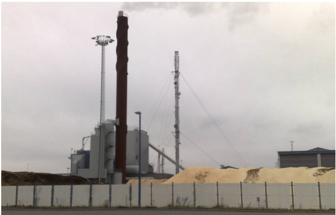
Kuva 9. Kemin kaukolämpövoimalaitos sijaitsee Karjalahdella
