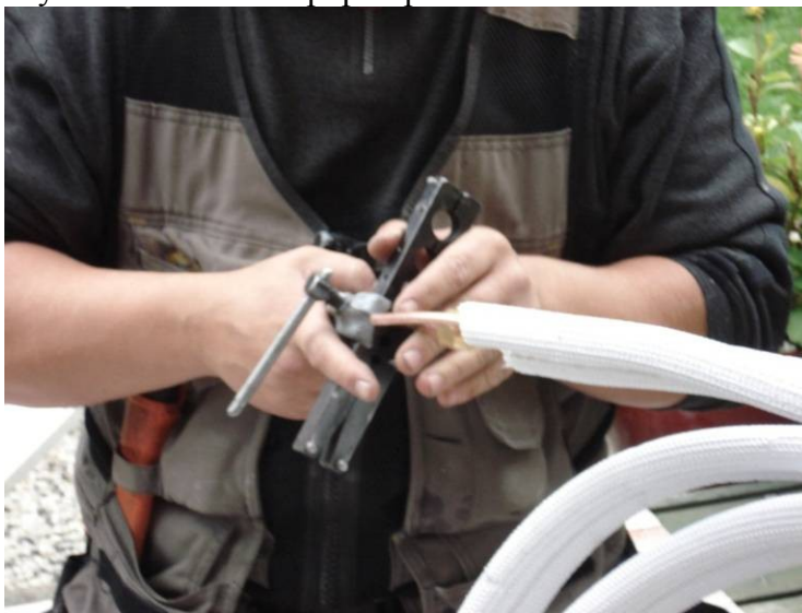
Kuva 44. Oikeat työvälineet ovat tärkeä osa asennusta
