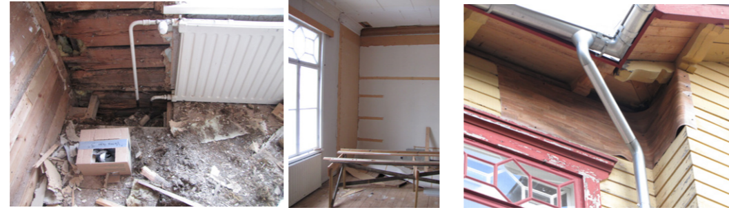
kosteuvaurio myös sisäpuolella pintarakenteet purettu - kuivatus
