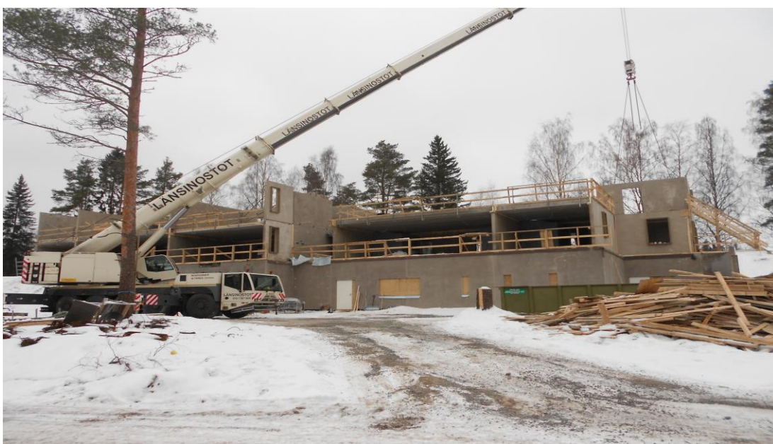
Kuva 8. Kohteen rakennustyömaa helmikuussa 2014
