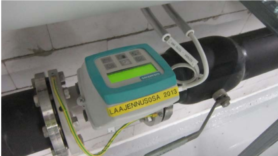
Kuvio 11. Vesimittari kylmän veden runkolinjassa.
