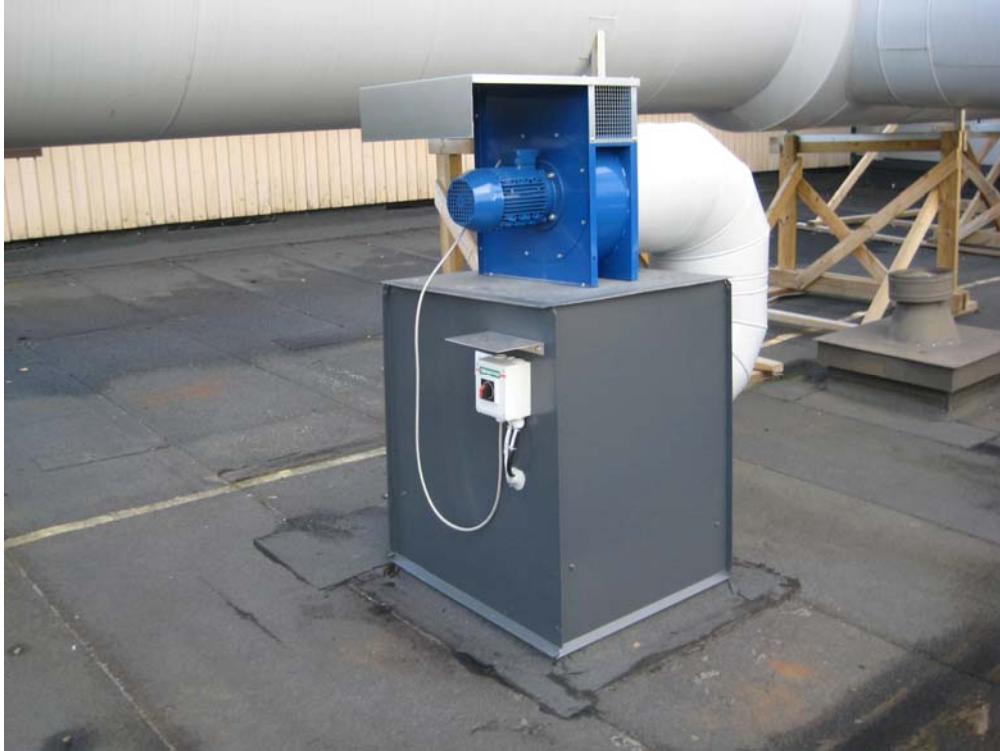
Kuvio 14. Hiilidioksidin erillispoistopuhallin katolla.
