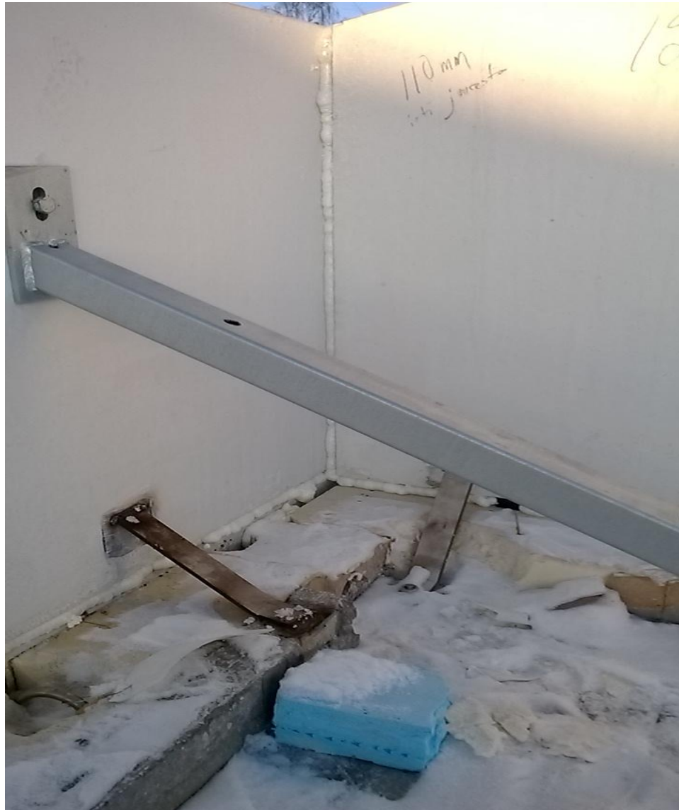
Kuva 9. Julkisivuelementtien saumojen uretaanivaahdotus.
