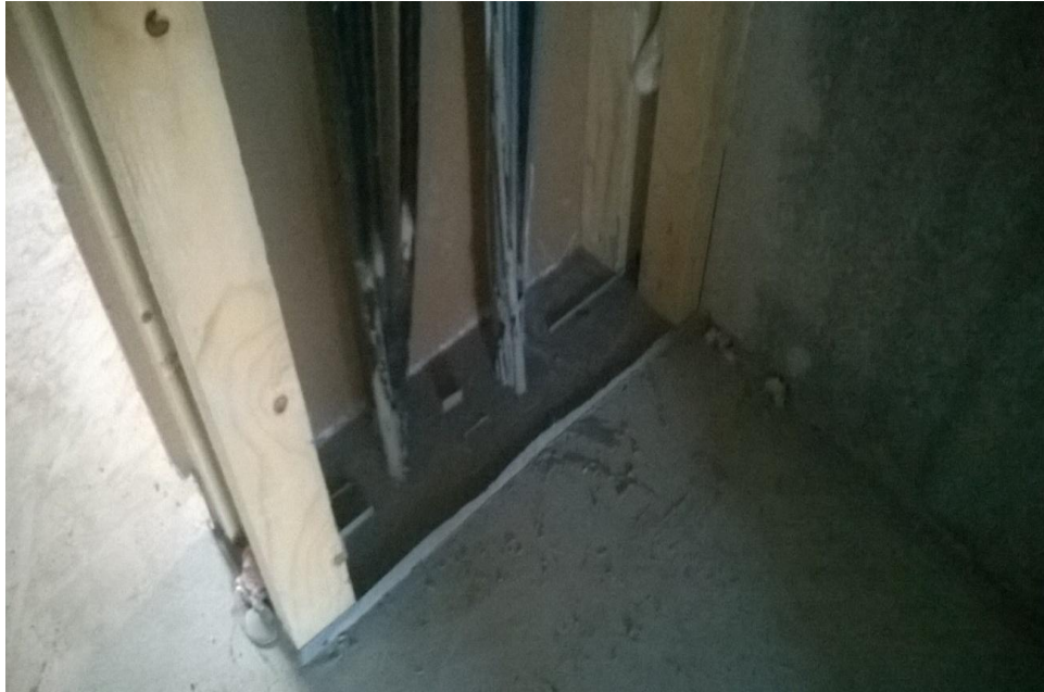
Kuva 16. Asuntojen kipsiväliseinän juuri umpeen valettuna. Ratkaisu on ilmatiivis.
