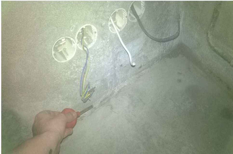
Kuva 15. Elementtien saumavalun ilmatiiviyyden tutkintaa merkisavun avulla ensimmäisessä painekokeessa 13.2.2014.
