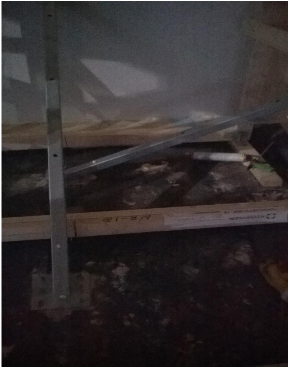
Kuva 10. Julkisivuelementtien tuet ullakkotilassa. Alaosat on täytetty uretaanivaahdolla.
