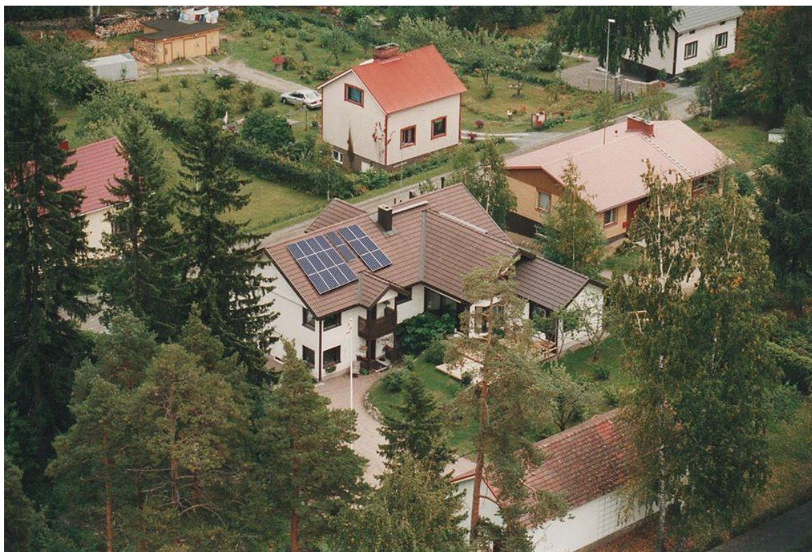
Kuva 11. Aurinkopaneelien suuntaaminen ja sijoitus kohteessa. (Henri Ilanen. 2014.)
