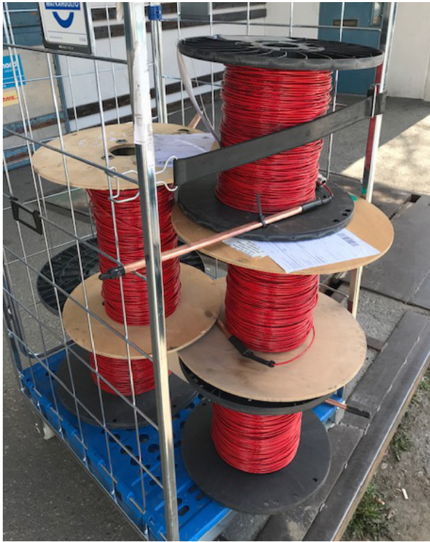
Kuva 12. DTS-kaapelit valmiina asennettavaksi Educityn energiakaivoihin.
