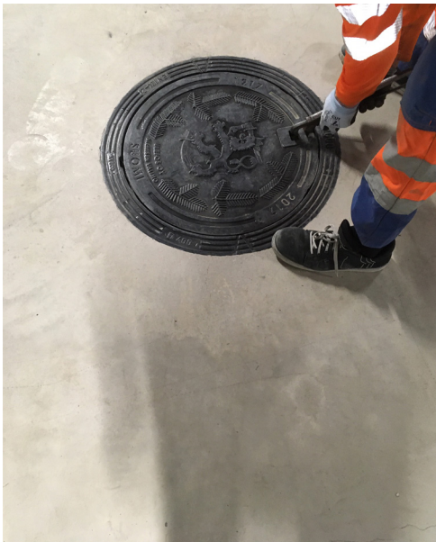
Kuvat 13 ja 14. Energiakaivot ovat tarkastuskansien alla alimmassa kerroksessa Educityn pysäköintihallissa.
