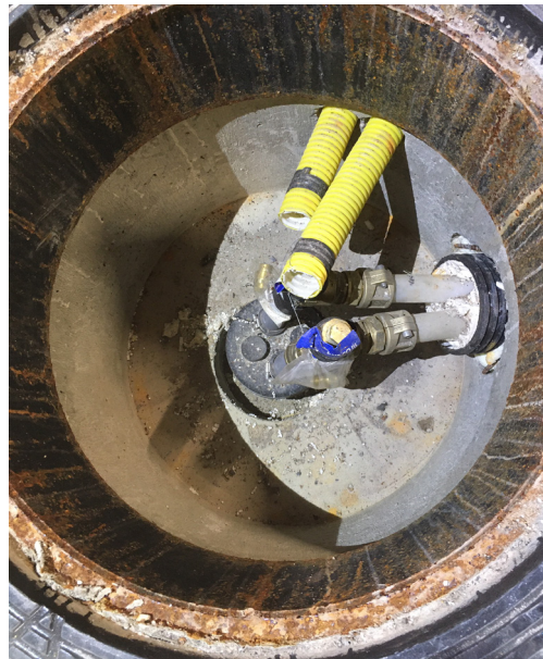
Kuvat 13 ja 14. Energiakaivot ovat tarkastuskansien alla alimmassa kerroksessa Educityn pysäköintihallissa.
