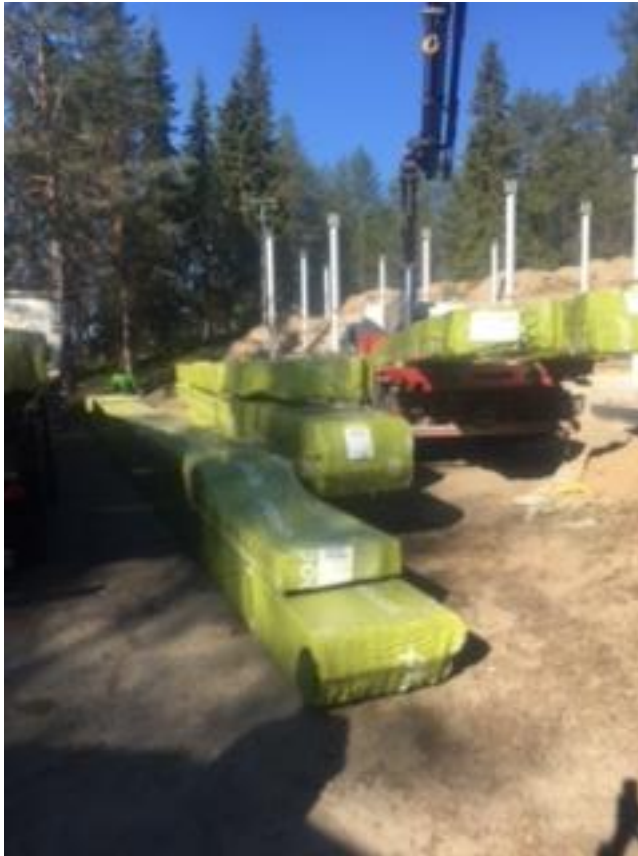
Kuva 11. Liimapuut saapuivat työmaalle.
