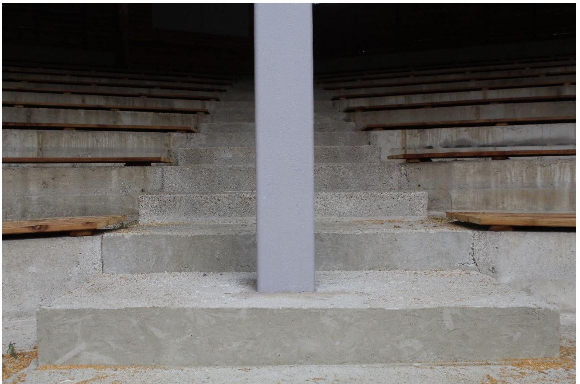
Kuva 6. Katsomorakenteet korjattuna alkuperäiseen kuntoon runkoasennuksen jälkeen.
