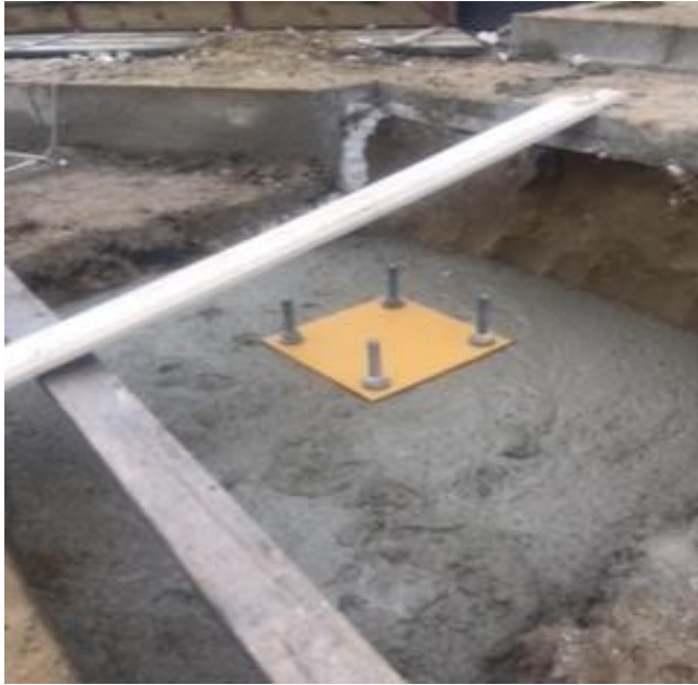
Kuva 5. Olemassa olevaa katsomorakennetta puretaan sen verran, että anturat saadaan rakennettua ja teräspilarit asennettua.
