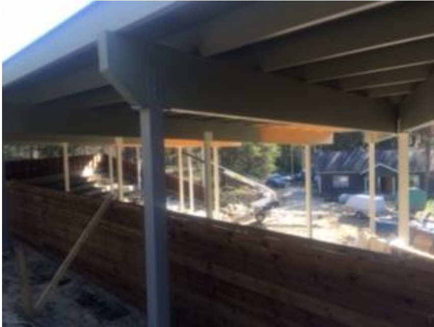
Kuva 18. Yleiskuva työmaalle yläkatsomosta.
