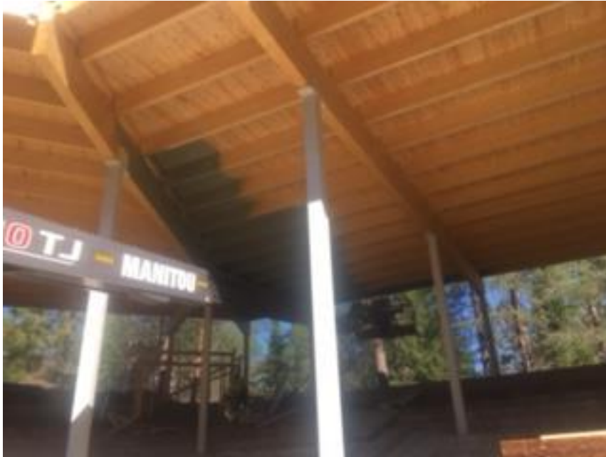
Kuva 17. Palo- ja homesuojamaalausta kurottajalla.
