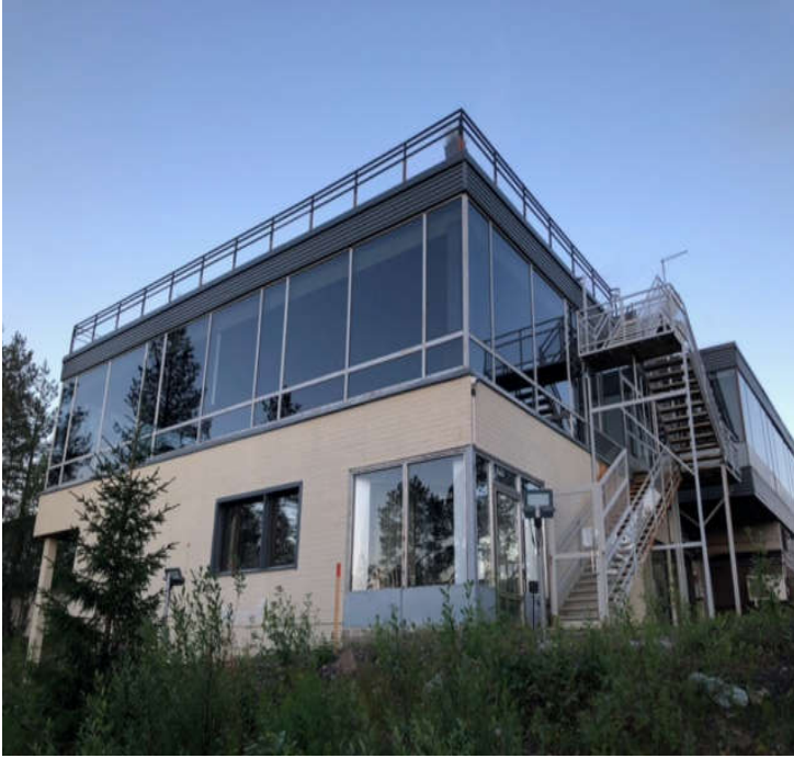
KUVA 10. Hotellia on laajennettu myös alkuperäisestä seinälinjasta ulospäin sekä kattoterassilla, joka aukeaa pohjoisrinteen puolelle
