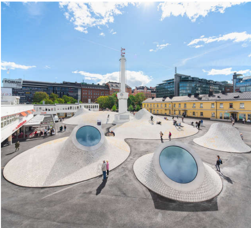
KUVA 20. Lasipalatsin aukiolla Helsingissä on kolmen eri vuosisadan rakennuksia uusimpana Amos Rex, jonka rakennusosat luovat ulkotilassa mielenkiintoa sisätilojakin kohtaan (Rakennustallisuus 2018)
