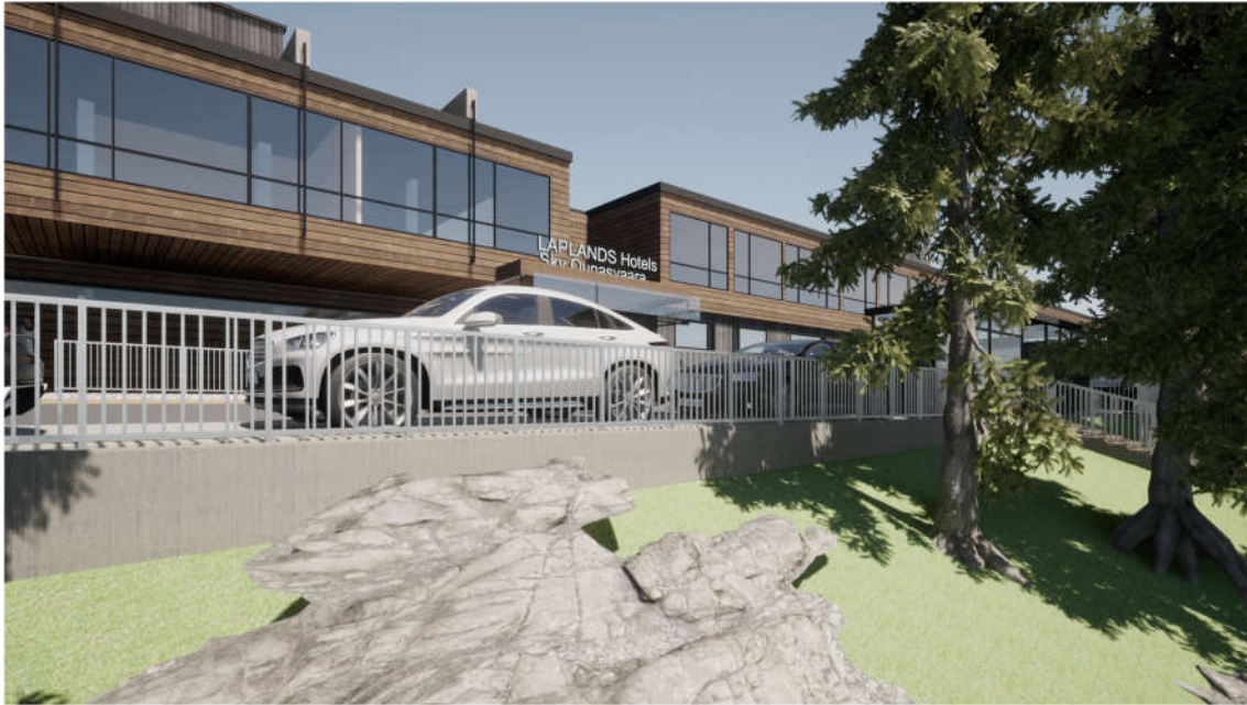
KUVA 38. Havainne kuvassa muuri ja kaide paikoitusalueen ja jyrkän rinteän välissä
